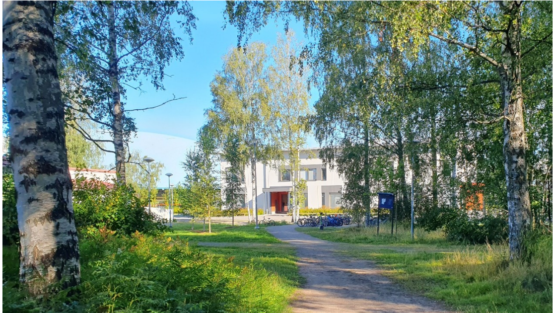
Jousenkaaren koulun eteläpääty on julkisivuiltaan vaalea. Seinissä on harmaata tehosteväriä ja sisäänkäynneissä lisäksi oranssin ja punaisen sävyjä.
