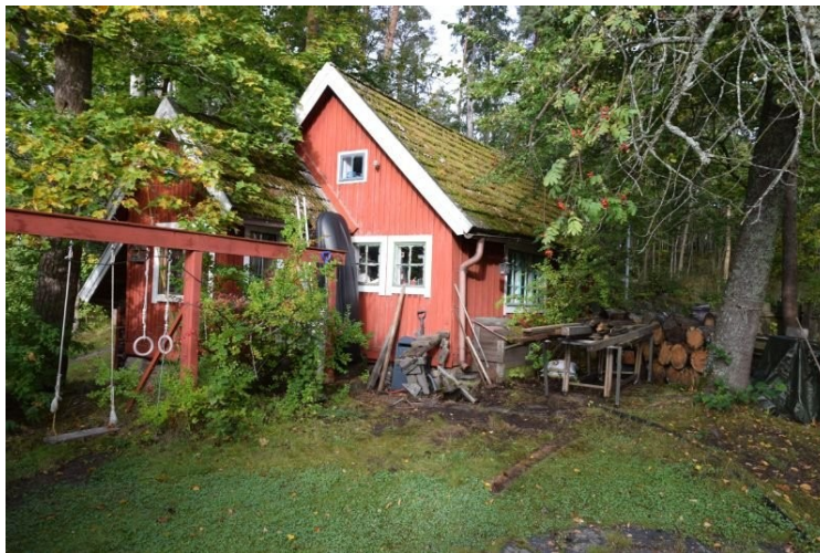
Kuva 11. Valapolku 15:n pihapiiriin kuuluva piharakennus. Kuva: Jyri Vilja, 2024.
