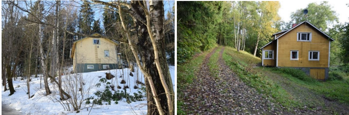
Kuva 13. Vasemmalla Valapolku 9:ssa sijaitseva tyhjiillään oleva asuinpienitalo, jolle on haettu ja saatu purkamislupa. Kuva: Marja Sahlberg, 2015. Oikealla Valokuva Valapolku 13:ssa sijainneesta tyhjiillään olevasta asuintalosta. Rakennus on purettu vuonna 2025. Kuva: Jyri Vilja, 2024.
