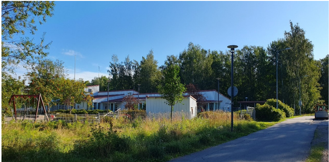
Jousenkaaren päiväkoti on matala ja julkisivu polveilee rakennuksen osien mukaan.
