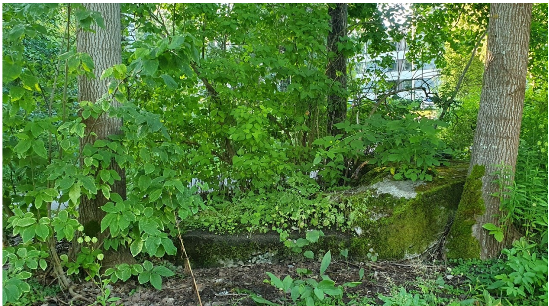
Betonisesta linnoitusrakenteesta on säilynyt osia, vaikka sen viereen rakennettiin 1960-luvulla opettaja-asuntolat. Kuva on eteläisemmän tukikohdan XXXIII:3 alueelta loppukesältä 2025.
