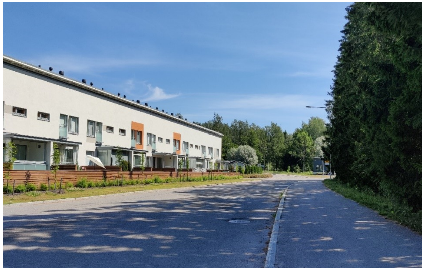
Kuva yllä: valokuva Masalantieltä. Kaavamuutosalueella sijaitseva kuusialta kuvassa oikealla. Kuvassa vasemmalla Hirsalantie 2:n rivitaloja. Espoon kaupunki 07/2021.
