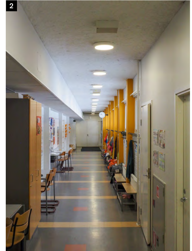
↑ Ensimmäisen kerroksen käytävätila. Peruskorjausvaiheessa käytävälle lisättiin katon alas-lasku ja koillispäättyyn lisättiin wc-tilalajennus vanhojen ikkunoiden paikalle. Wc-tiloihin johtavat ovet näkyvät kuvassa oikealla.
