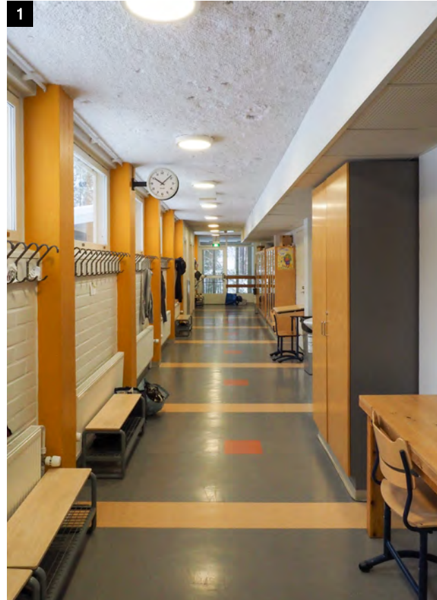
↑ Toisen kerroksen käytävätila. Käytävien pinnat ja väritys ovat vuoden 1999 muutosvaiheesta. Tilahahmo on pääosin alkuperäinen.
