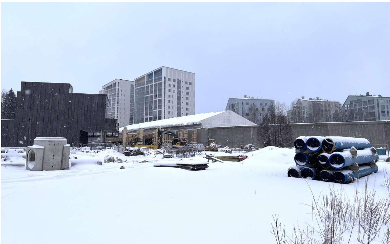
Meritien nostotyöt Finnoon metroaseman Meritien sisäänkäynnin edessä vuodenvaihteessa 2025–2026. Kuva: M. Partanen.
