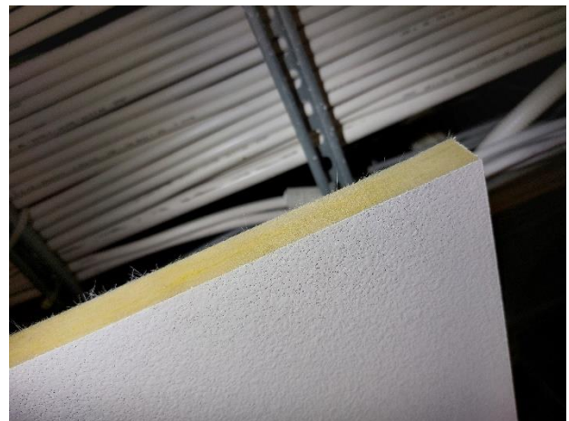
Akustiikkalevyjen reunat on pinnoittamattomia.
