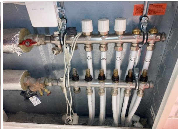
Jakotukki D-osaan lattialämmitykseen.
