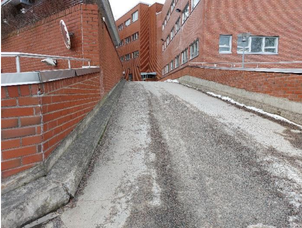
Kiinteistön sisäpihan ajoluiska.
