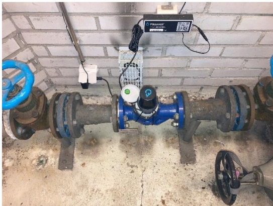
C- osan vesimittari.
