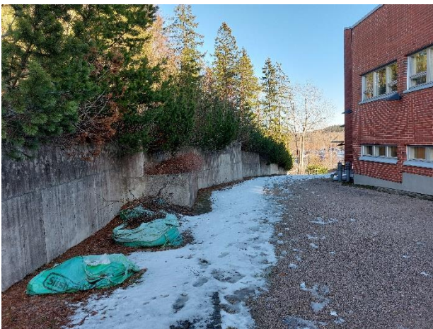
Kiinteistön takapihan tukimuuri.
