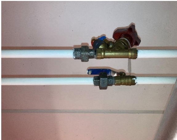
D- osan linjasäätöventtiilit.
