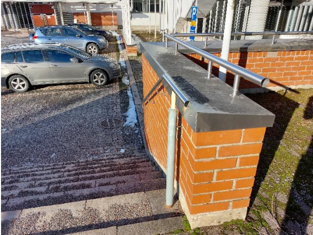
Kiinteistön pääsisäänkäynnin edustan tukimuuria.
