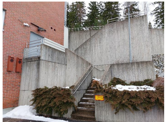
Kiinteistön D-osan päädyn tukimuuria.
