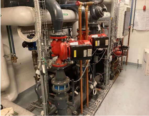
C-osan lämmönjakokeskus.
