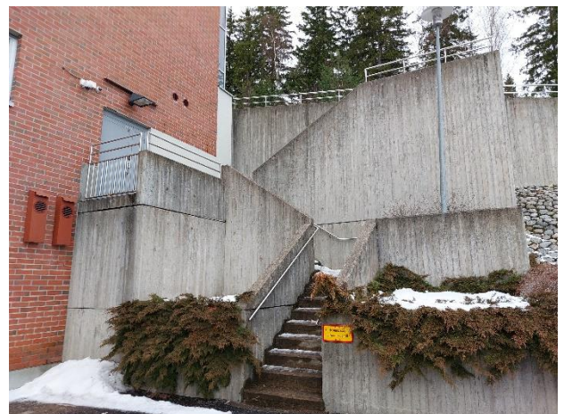
Kiinteistön D-osan päädyn ulkoportaat.
