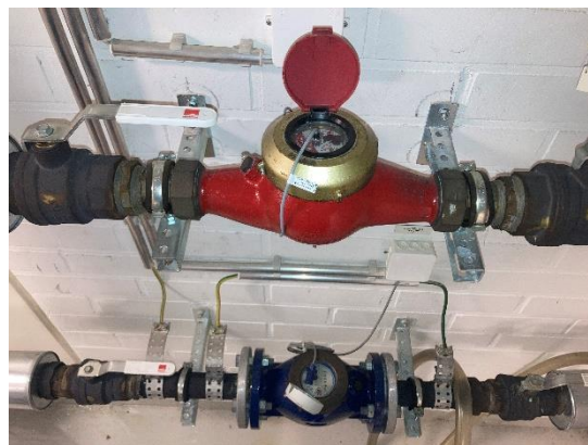
D- osan vesimittari.
