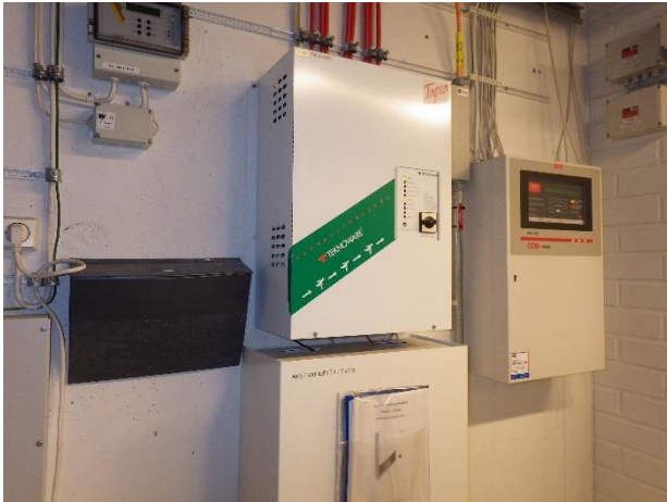
Turvavalo- ja paloilmotinkeskus D-osan nousukeskuksessa.
