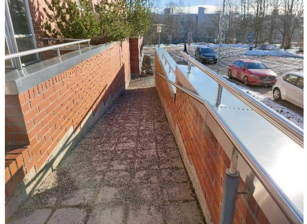
Kiinteistön pääsisäänkäynnin luiskan tukimuuri.
