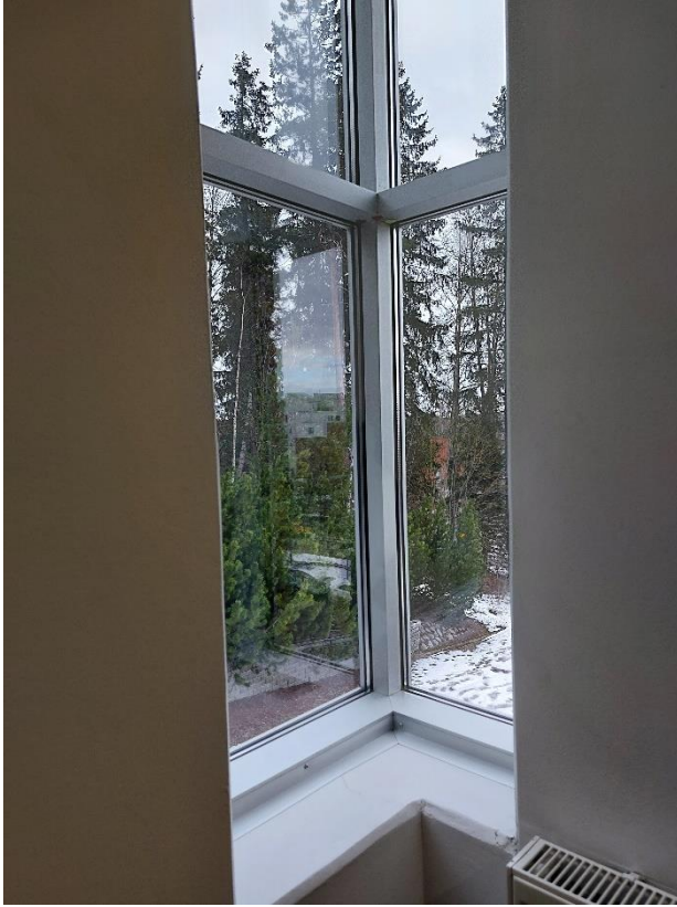
Porraskäytävän kiinteitä ikkunoita.
