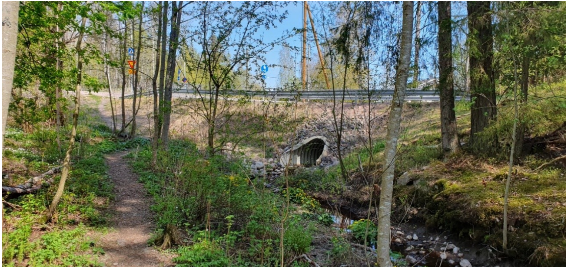
Kuva: Henttaanpuron varren polku ja Väli-Henttaantien silta länsipuolelta tarkasteltuna. © Espoon kaupunki, kevät 2024.
