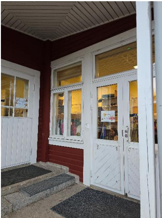
Kuva 80. Pääsisäänkäynnin ovet on uusittu.
