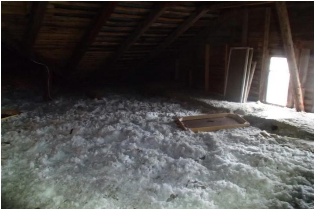
Kuva 113. Yleiskuva rakennuksen eteläpäädyn vinttitilassa. Kesialueella on lisälämmöneristeenä puhalluseristeet ja reunoilla eristelevyt.
