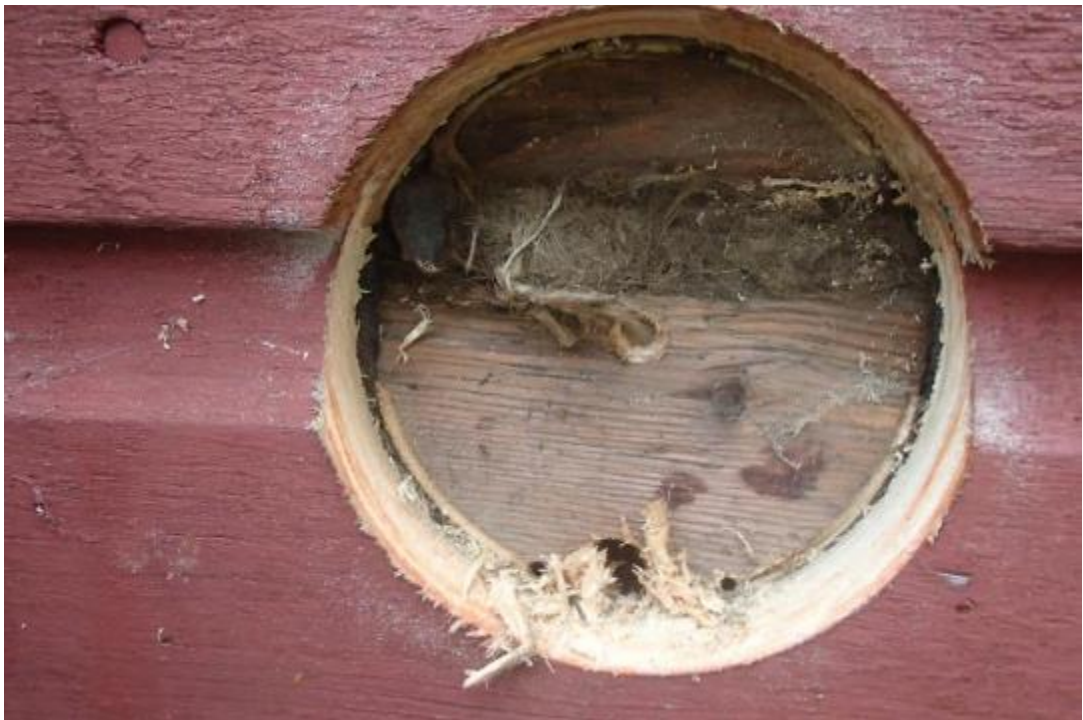
Kuva 2. Rakenneavaus J3 ulkovaipparakenteeseen.
