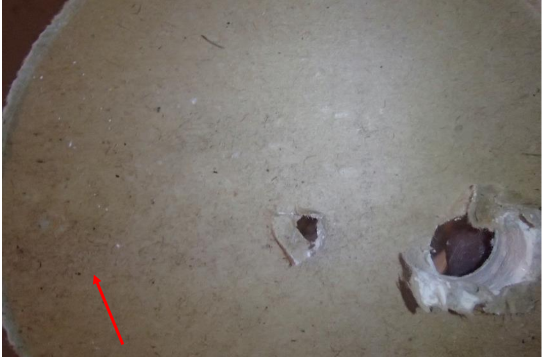
Kuva 34. Sisäpuolen kipsilevyjen kartonkipinnoilla havaittiin lievää tummentumista.
