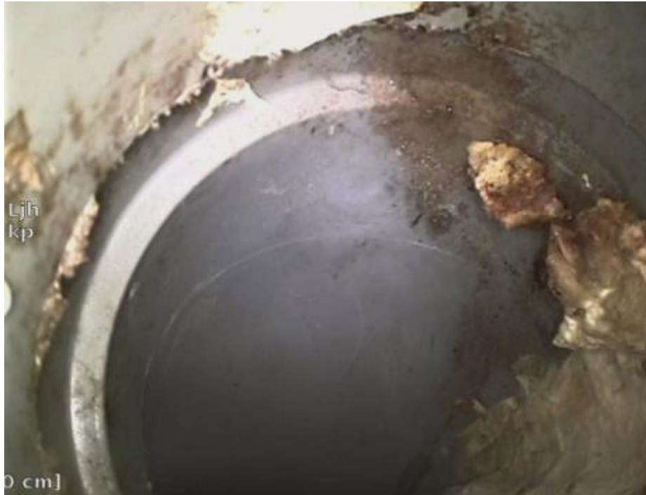
Kuva 145. Lämmönjakohuoneen linjastossa ei havaittu poikkeamia.
