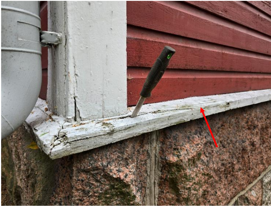
Kuva 27. Tippalautojen päällä kasvaa kosteutta sitovaa kasvillisuutta.
