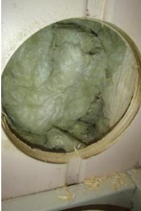
Kuva 5. Rakenneavaus SJ2 ulkovaipparakenteeseen sisäkautta suoritettuna.
