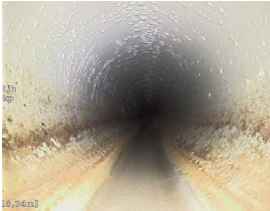
Kuva 147. Lämmönjakohuoneen linjaston kuvaus päättyi 18,04 metrin kohdalle. Linjasto rakennuksen ulkopuolella.
