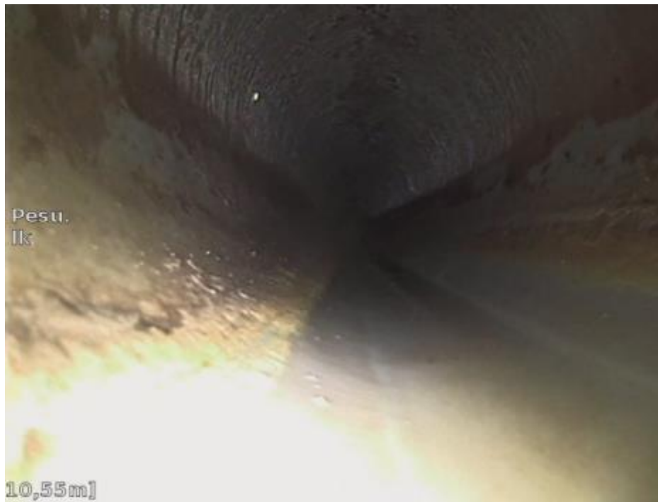
Kuva 144. Poikkeamia ei havaittu.
