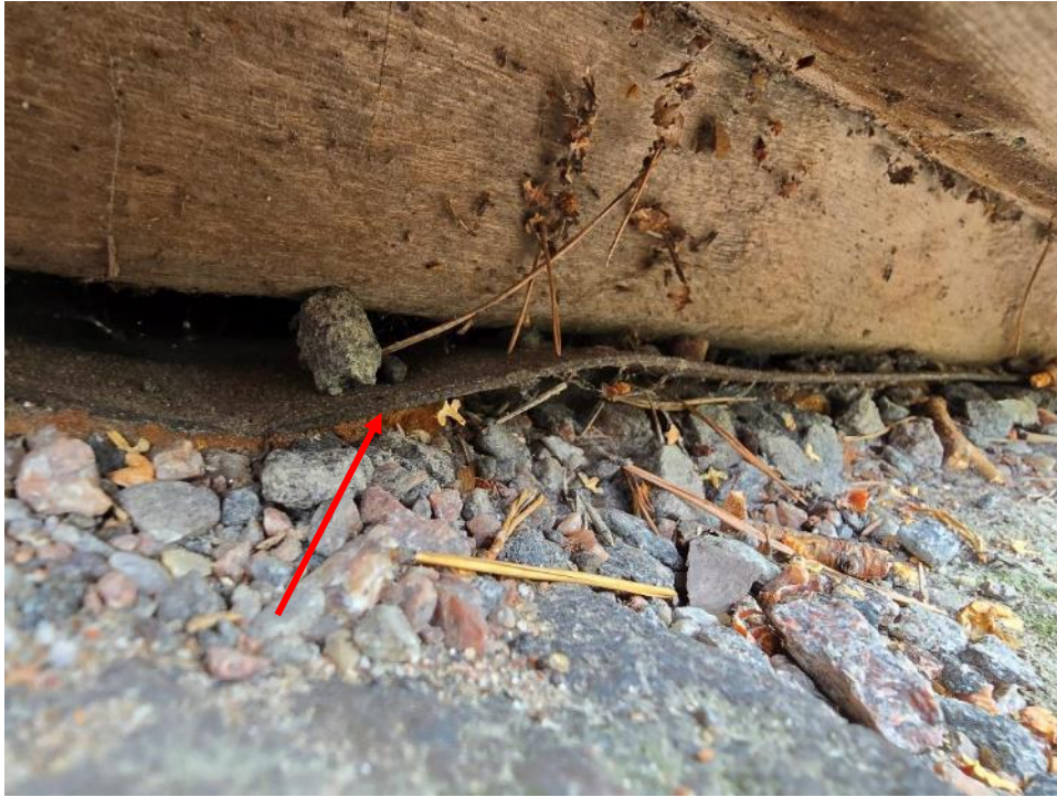
Kuva 37. Hirsirungon ja luonnonkivisokkelin välissä havaittiin bitumikermikaistaleet.
