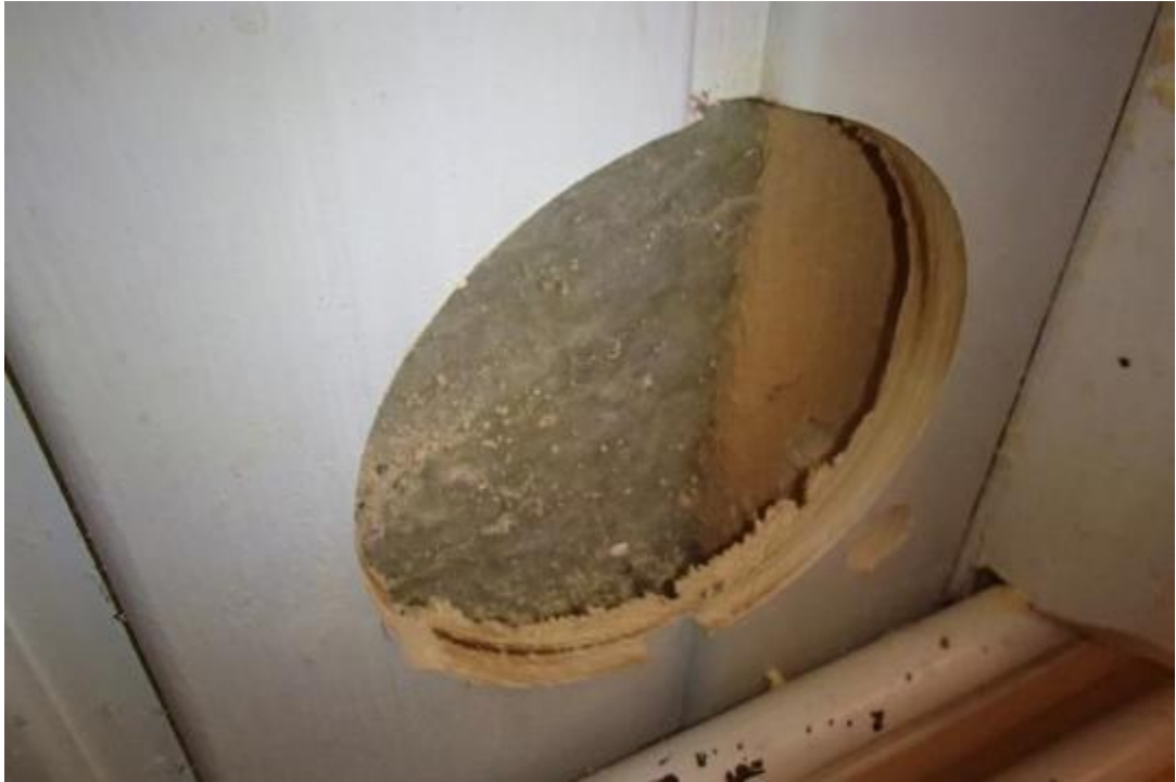
Kuva 6. Rakenneavaus SJ3 ulkovaipparakenteeseen sisäkautta suoritettuna.
