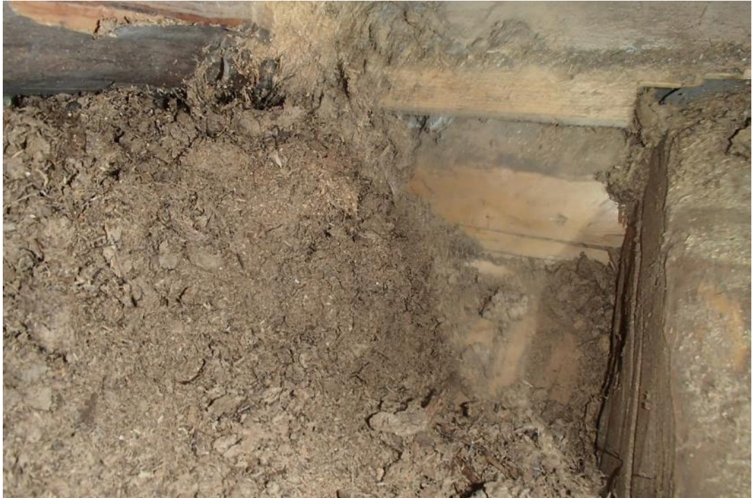
Kuva 120. Rakenneavaus, YP3, jakelukeittiön yläpuoleiseen yläpohjaan hirsirungon vierestä suoritettuna.
