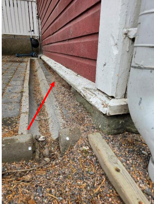
Kuva 38. Paikoin sokkelit ovat matalat.
