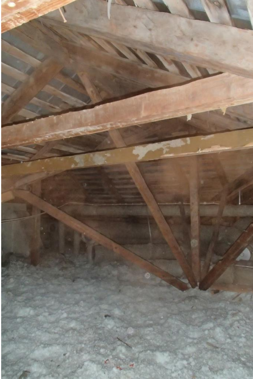
Kuva 115. Rakennuksen kattorakenteiden tuentaa eteläpäädyistä.
