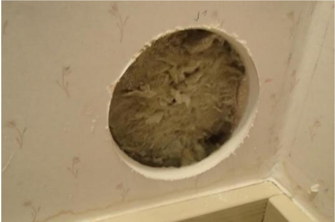
Kuva 4. Rakenneavaus SJ1 ulkovaipparakenteeseen sisäkautta suoritettuna.
