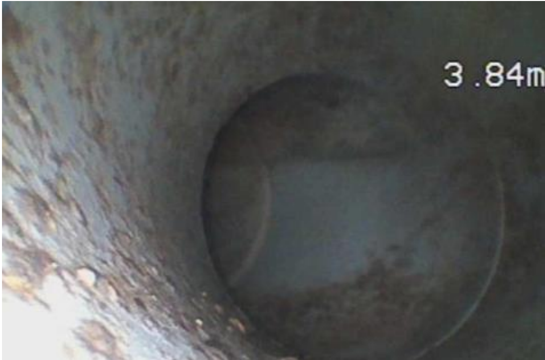
Kuva 137. Henkilökunnan pukuhuoneen suihkuhuoneen pohjaviemäreissä ei havaittu poikkeamia. Kuvaus päättyi 3,84 metrin päähän kaivolta.
