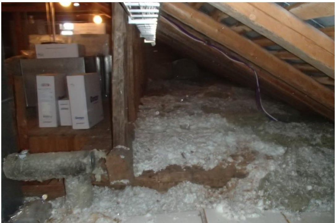
Kuva 117. Yleiskuva pohjoispäädyn yläpohjan vinttitilasta.
