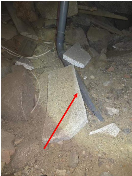
Kuva 110. Suurin osa viemäriputkista on eristämättömiä, mutta niissä on saattolämmitys.
