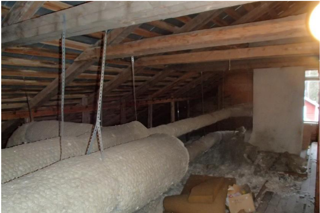
Kuva 116. Yleiskuva pohjoispäädyn yläpohjan vinttitilasta.
