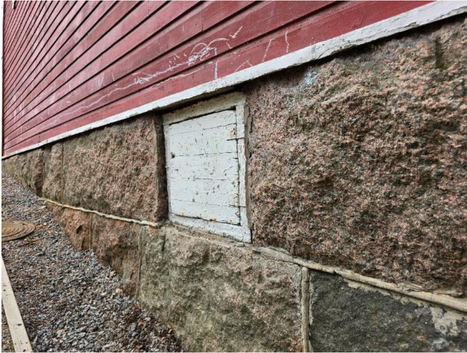
Kuva 107. Sokkelissa on tuuletusluukkuja.
