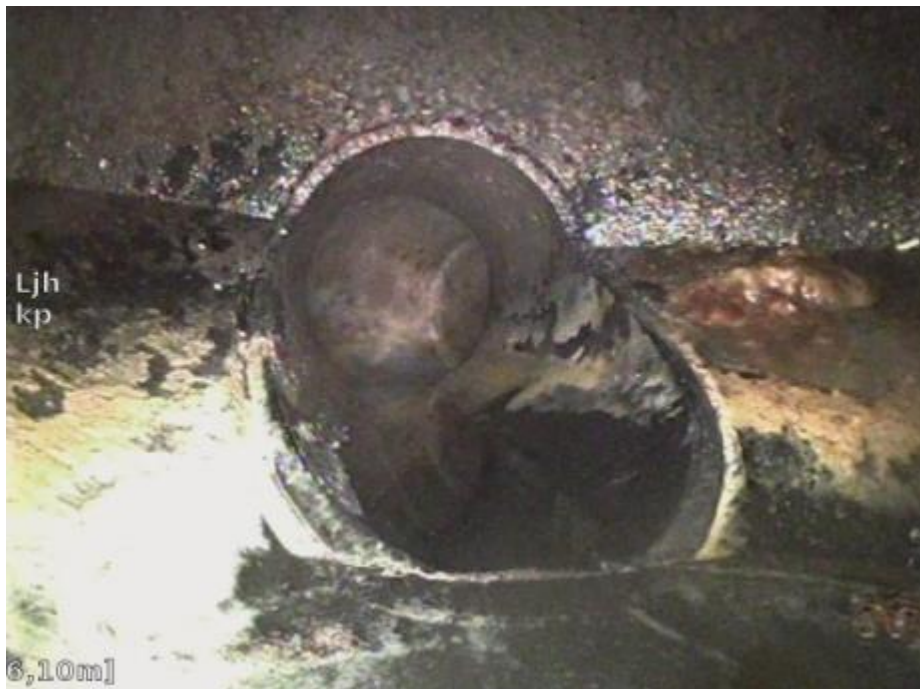
Kuva 146. Tarkastuskaivo rakennuksen ulkopuolelta.
