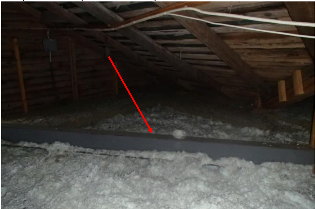
Kuva 114. Yleiskuva rakennuksen eteläpäädyn vinttitilasta, johon on asennettu lisätueksi teräksinen l-palkki.
