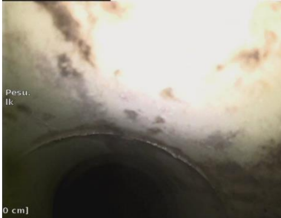
Kuva 143. Pesuhuoneen pohjaviemäreissä ei havaittu poikkeamia.
