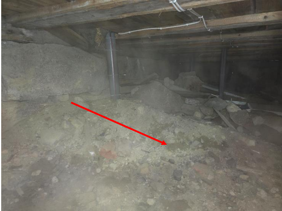
Kuva 100. Ryömintätilassa havaittiin ylimääräistä jätettä ja puumateriaalia sekä alapohjan maa-ainekset kaatavat keskialuetta kohden.
