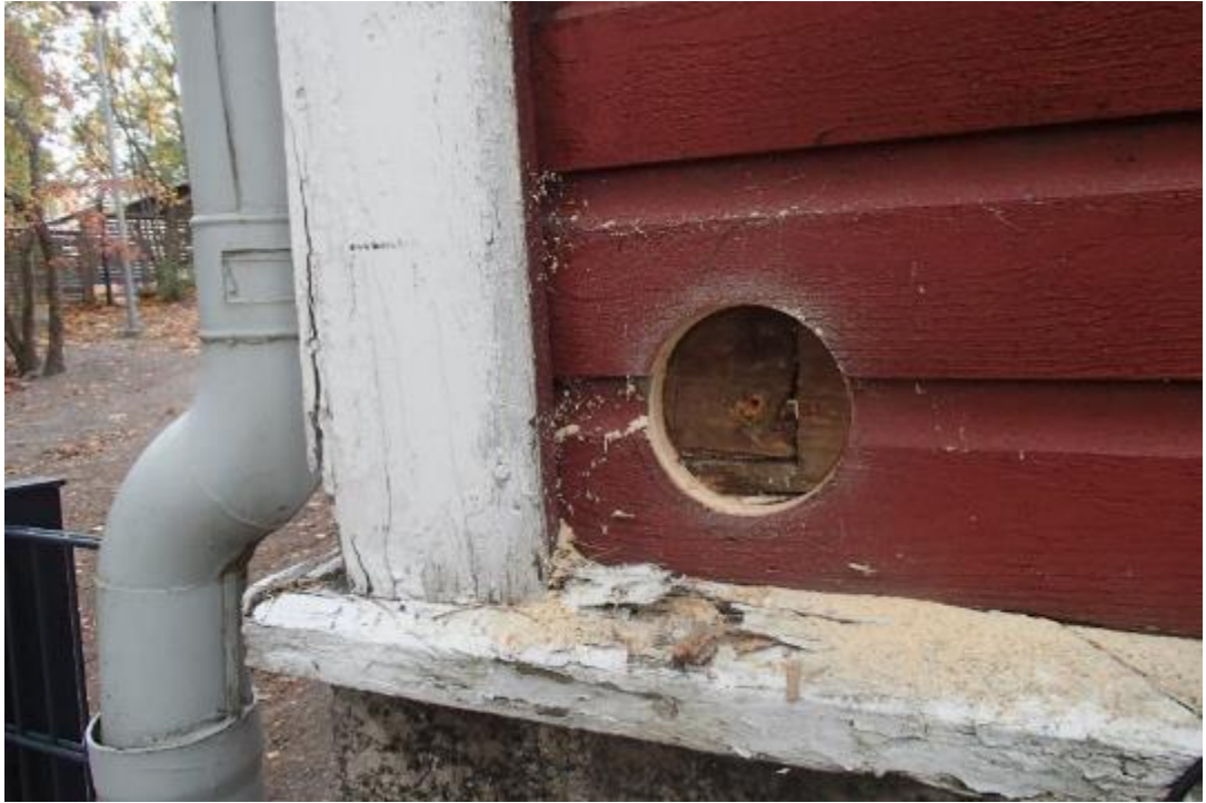
Kuva 3. Rakenneavaus J7 ulkovaipparakenteeseen.
