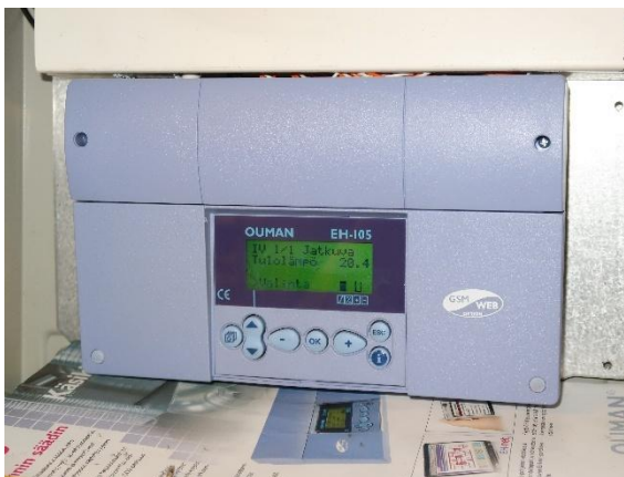
Kuva 92 Ilmanvaihdon säädin.
