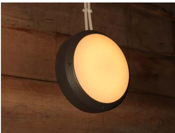
Kuva 82 Yleiskuva piharakennuksen pienoisoisloistelamppuvalaisimesta.
