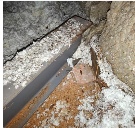
Kuva 19. Aikaisempi lisätuenta nojasi I-palkkiin, joka tukeutui tiililadonnan ja ulkoseinän hirsiseinän varaan.
