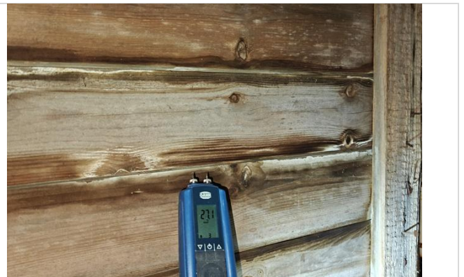
Kuva 23. Lähikuva julkisivulaudoituksesta ullakon puolelta.
