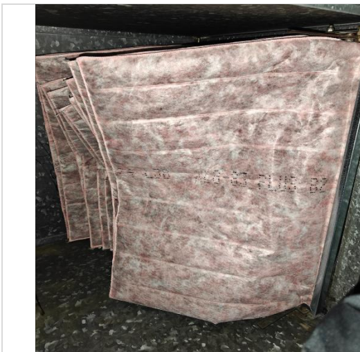
Kuva 42. Suodattimet olivat puhtaat ja suodatinkotelo puhtas. Merkintöjen mukaan vaihdettu 28.7.2025.
