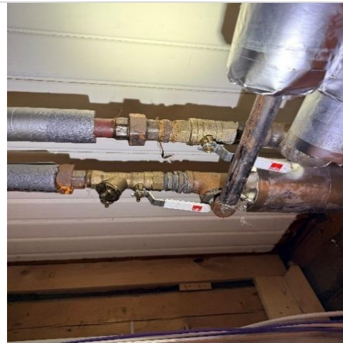
Kuva 63. Lämpölinjoja alakattotilassa
