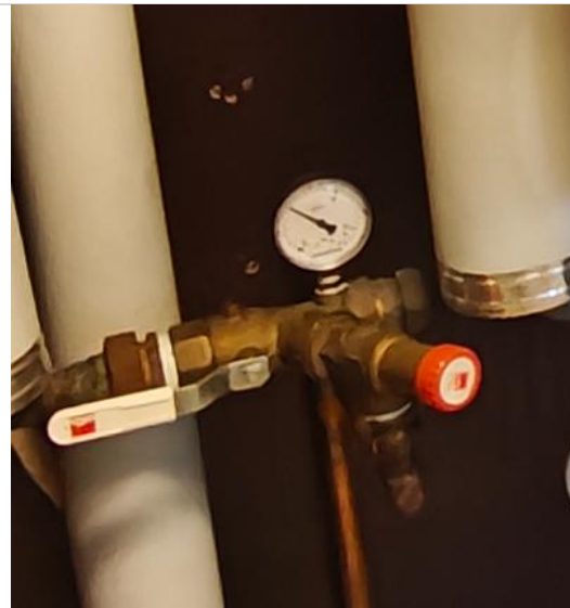
Kuva 57. Käyttövedenpaine ennen lämmönsiirintä oli 3-4 bar, mikä on normaali ja alaisempi kuin v. 2021 kuntoarviossa.
