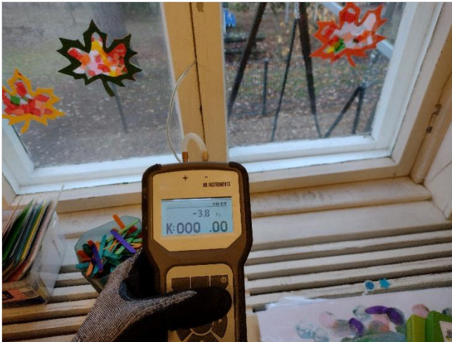
Kuva 31. Paine-ero sisä- ja ulkoilman välillä oli tutkimushetkellä -4...-3 Pa välillä.
