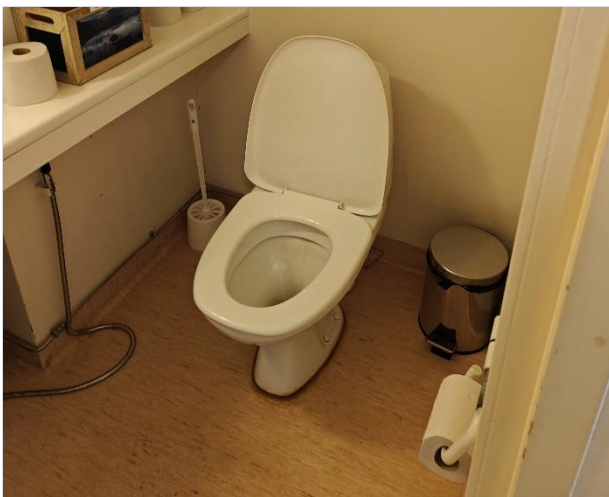
Kuva 58. WC-istuin uusittu edellisessä peruskorjauksessa.
