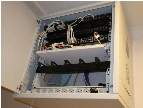
Kuva 88 Yleiskaapelointijärjestelmän jakamo.
