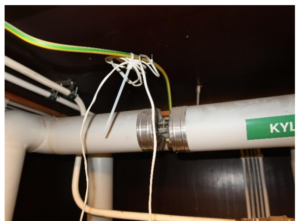
Kuva 71 Putkistomaadoitus.
