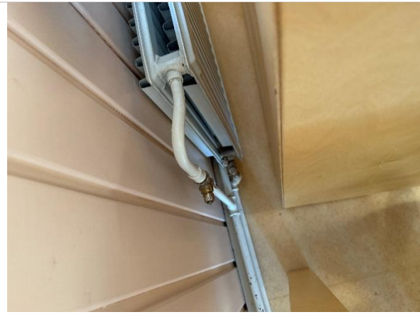
Kuva 65. Patteritermostaatti on irti
