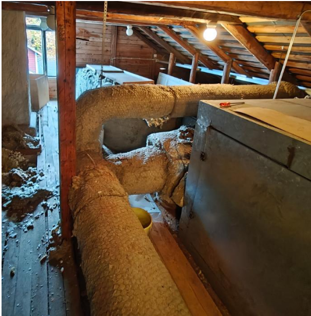
Kuva 41. Yleiskuvat IV-kone sijaitsee ullakolla ja tuloilma on jatkuvasti toiminnassa 1/1 teholla.
