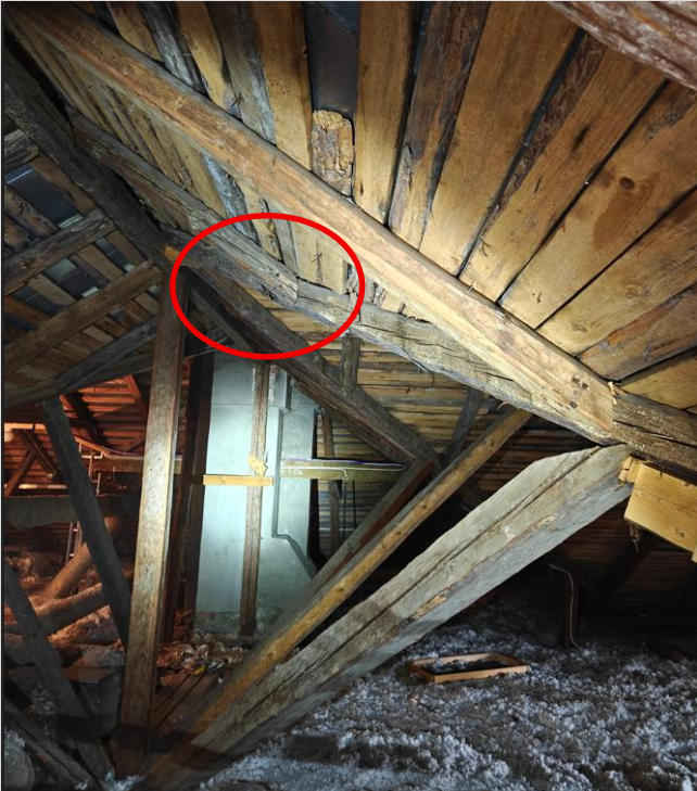
Kuva 20. Havaittu kattotuolin notkahdus.
