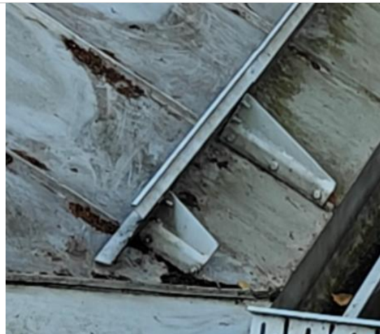
Kuva 10. Lumiasteet on kiinnitetty saumoihin, kuten pitääkin.
