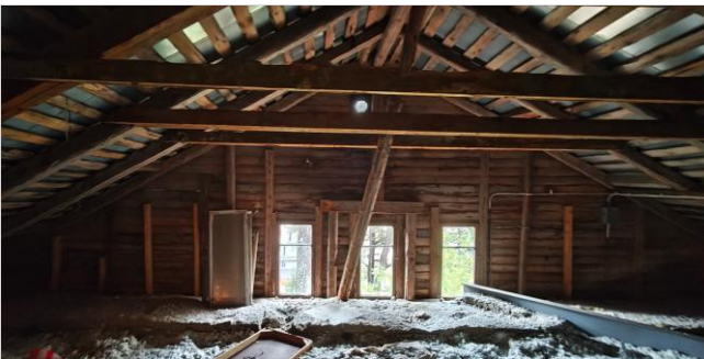
Kuva 20. Havaittu kattotuolin notkahdus.
