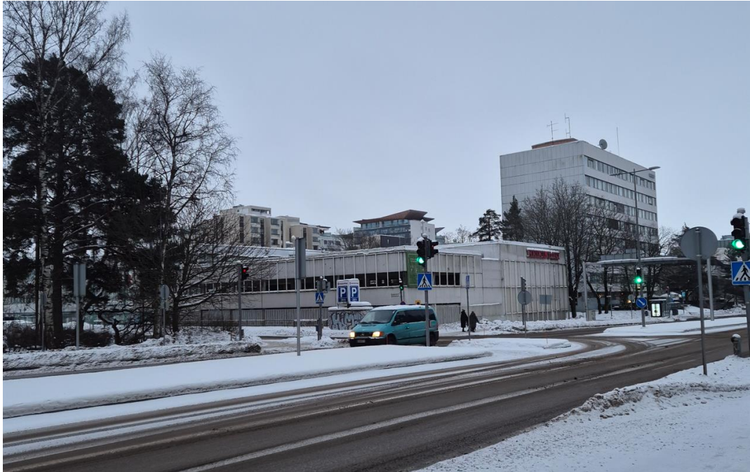
Kuva 7 Pohjantie ja Heikintorin pysäköintilaitos takanaan Raitinlukko. Kuvattu talvella 2026.
