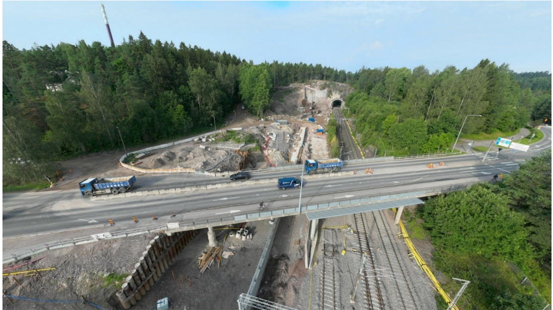
Kuva 10. Näkymä Kaupunkiradan työmaan edistymisestä Kaupunginkallionrinteen kaava-alueen kohdalla 23.7.2025. Kuvalähde: Väylävirasto.
