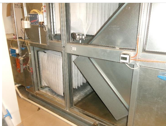
Kuva 103. Suodattimien kokoa oli muutettu, koska edelliset olivat olleet liian pitkiä, mutta nykyiset ovat hieman liian lyhyet ja mahdollistavat ohivuotoja.
