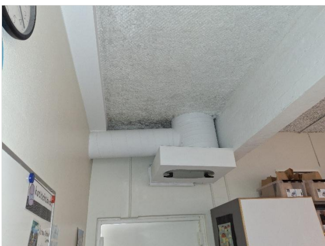
Kuva 58. Käytävissä ja osissa luokkatiloja on katossa lastuvillalevyjen päälle ruiskutettu luonnonkuitupohjainen pinnoite.
