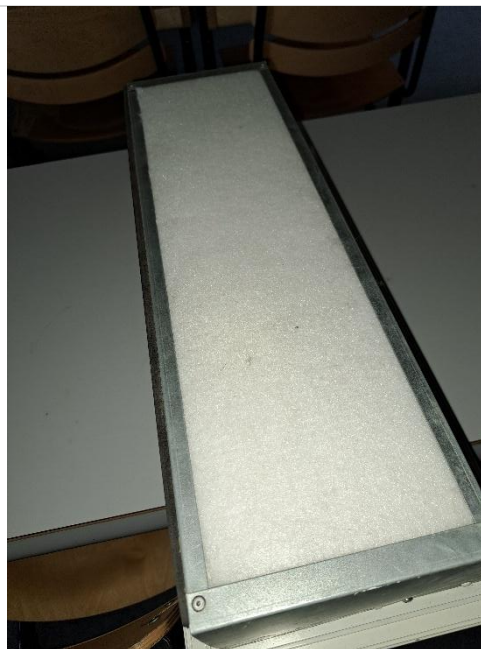
Kuva 105. Hajottajissa olevat äänenvaimentimet olivat puhtaita, kuvassa luokkahuone 111 tuloilman äänenvaimennin.
