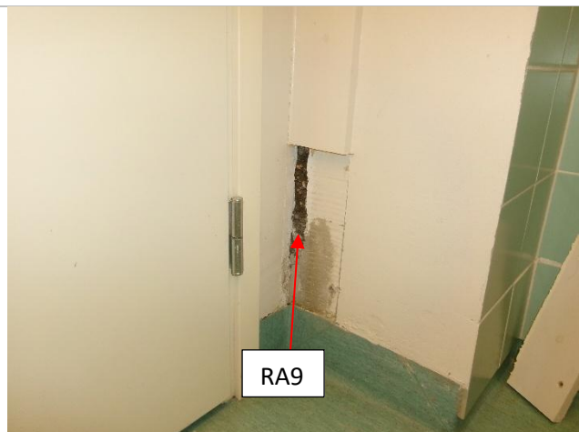
Kuva 65. Pohjakerroksen entisen maanvastaisen ja nykyisen väliseinän rakennetutkimus.
