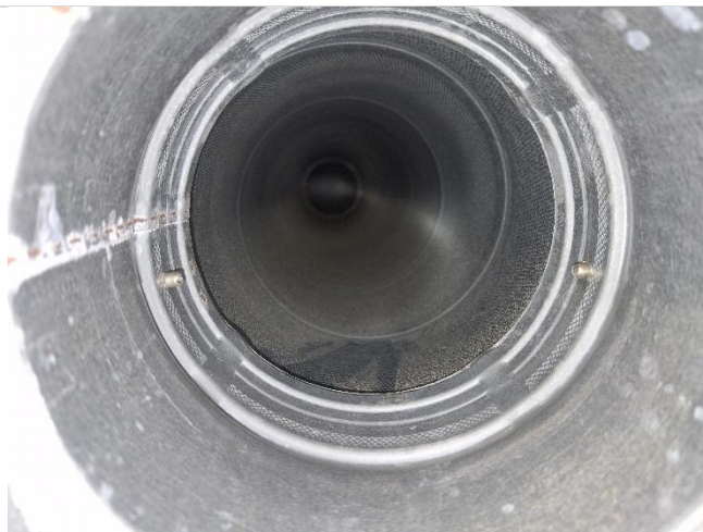
Kuva 105. Hajottajissa olevat äänenvaimentimet olivat puhtaita, kuvassa luokkahuone 111 tuloilman äänenvaimennin.
