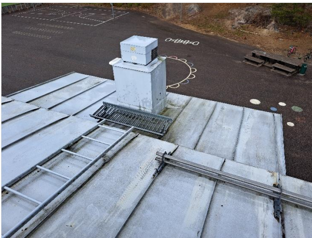
Kuva 86. Korotetun osan ja wc-tornin katto.
