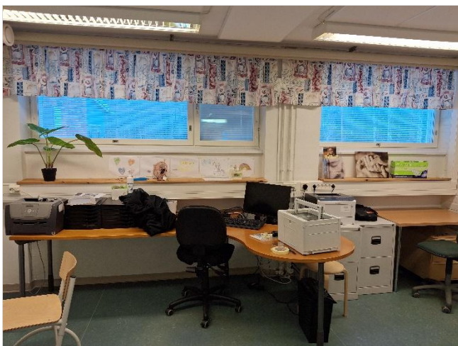
Kuva 44. Terveystenhoitajan huoneen 010 ulkoseinärakenne on uusittu.
