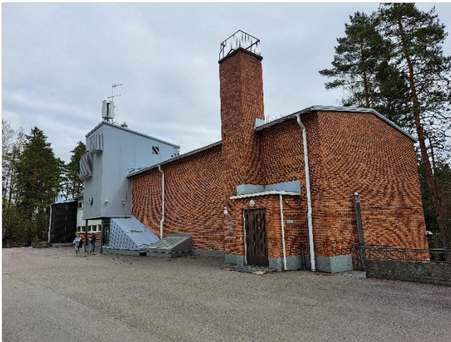
Kuva 5. Pihan puolella päällysteenä on kohtalaisen hyväkuntoinen asfaltti. Kaadot ovat riittävästi pois päin rakennuksesta.
