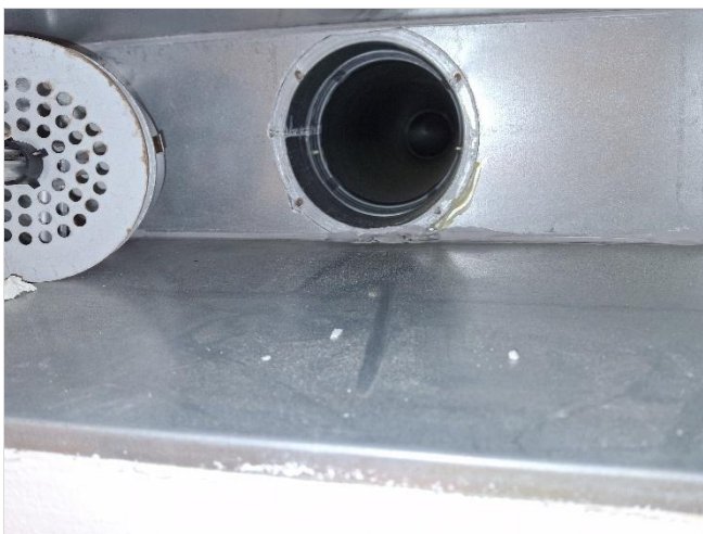
Kuva 108. Terveystieteiden huoneen 010 hajottajalaatikon sisällä oli hieman tasoitteen paloja, ne ovat jääneet sinne todennäköisesti huoneen pintaremontista.
