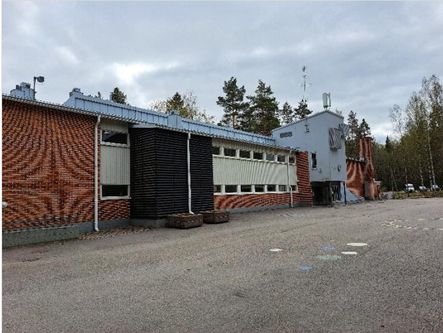
Kuva 46. Kuvassa vasemmalla tumma uloke on wc-torni ja oikealla harmaa lisäosa on iv-konehuone.
