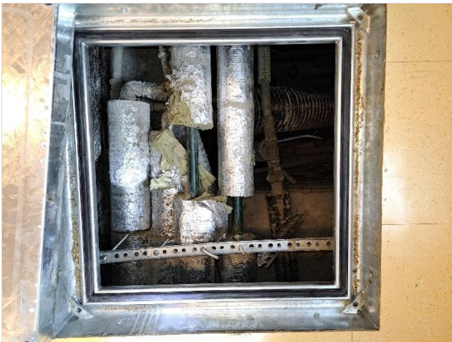
Kuva 23. Ruokasalin 036 lattiassa on kaasutiivis tarkastusluukku
