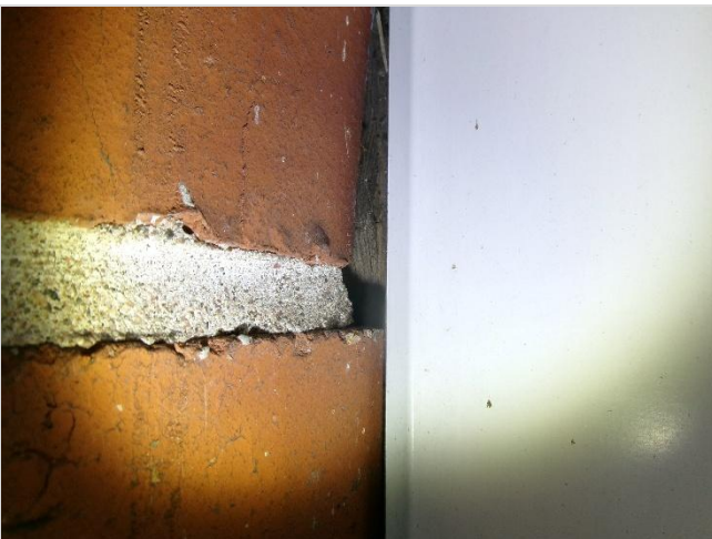
Kuva 52. Ikkunapellitykset olivat paikoin epätiivit.
