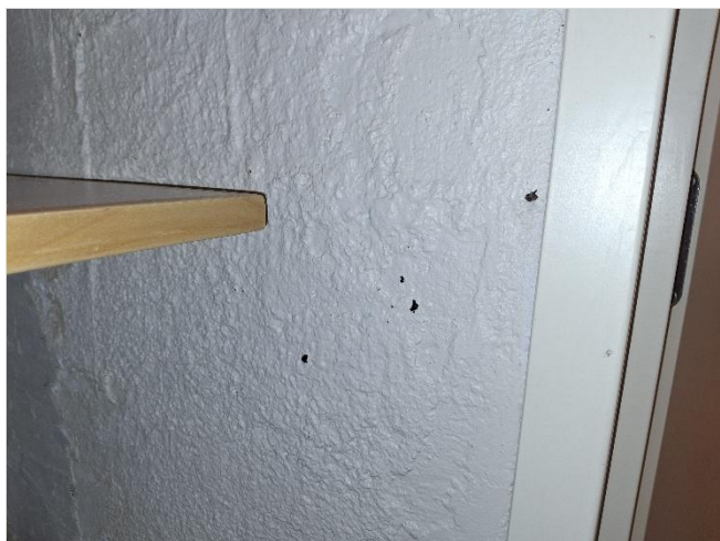
Kuva 66. Alkuperäiseen ulkoseinärakenteeseen oli jätetty toiselle puolelle pikisively, joka oli peitetty maalilla.
