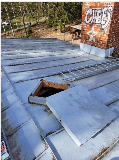
Kuva 82. Kulku yläpohjatilaan on vesikatolla olevien luukkujen kautta.
