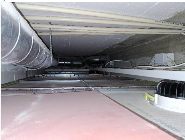
Kuva 60. Pohjakerroksessa osassa käytävää on reikäkipsilevyillä alaslaskettua kattoja.
