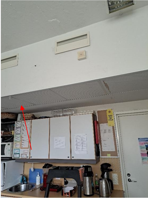
Kuva 71. Vanha sinetöity kulkuluukku sijaitsee opettajienhuoneen 207 katossa.
