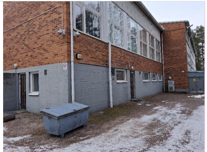
Kuva 6. Teknistentilojen ja terveydenhoitajan päädyssä rakennuksen vierustäyttönä on soraa/hiekkaa.
