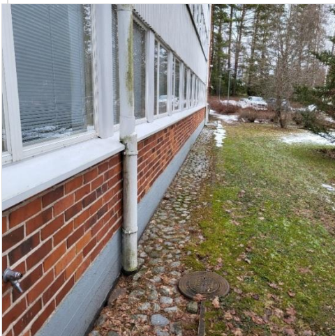
Kuva 7. Tien puoleisella sivulla sokkelin vieressä on mukulakiveys.
