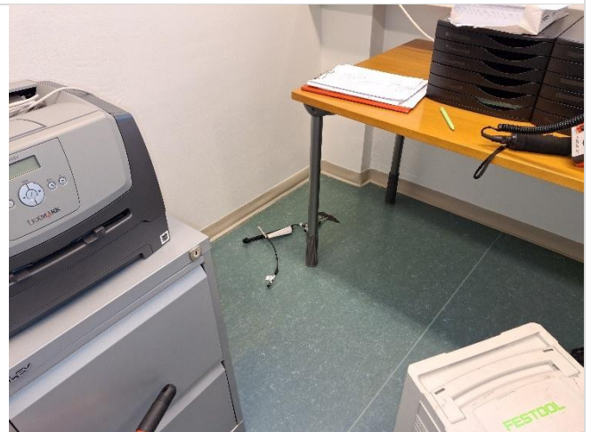
Kuva 18. Terveystilojen huoneessa 010 tarkastettiin linoleumin kunto ja tehtiin viiltomittaus VK1. Linoleumi oli kunnossa ja viiltomittauksen tulos oli normaali.
