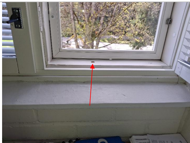
Kuva 36. Ikkunan tilkevälän tutkimus huoneessa 108.
