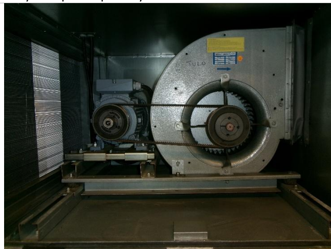
Kuva 101. Tuloilmakammiot olivat kohtalaisen puhtaat.
