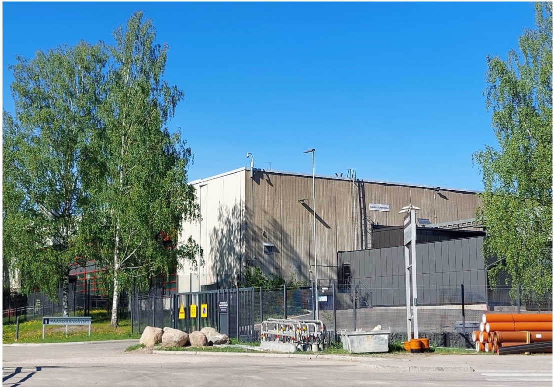
Rakennuksen hallimainen varasto-osa Sinimäentien puolella tonttia.
