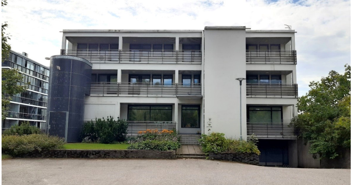
Kuva 2 Suunnittelualueella sijaitseva liikerakennus pohjoisesta kuvattuna.
