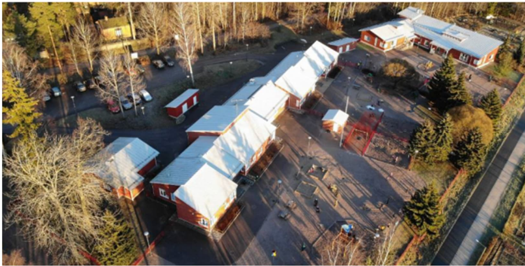
Ilmavalokuva kohteesta, keskellä Leppäsillan päiväkoti, vasemmalla asuntorakennus ja oikealla ylhäällä tyyppipäiväkoti Hiirulainen.
