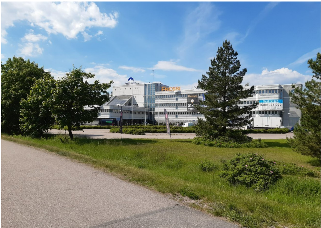
Kuva 3 Läntisessä korttelissa sijaitseva liikerakennus Länsiväylän varressa kulkevalta jalankulun ja pyöräilyn reitiltä.
