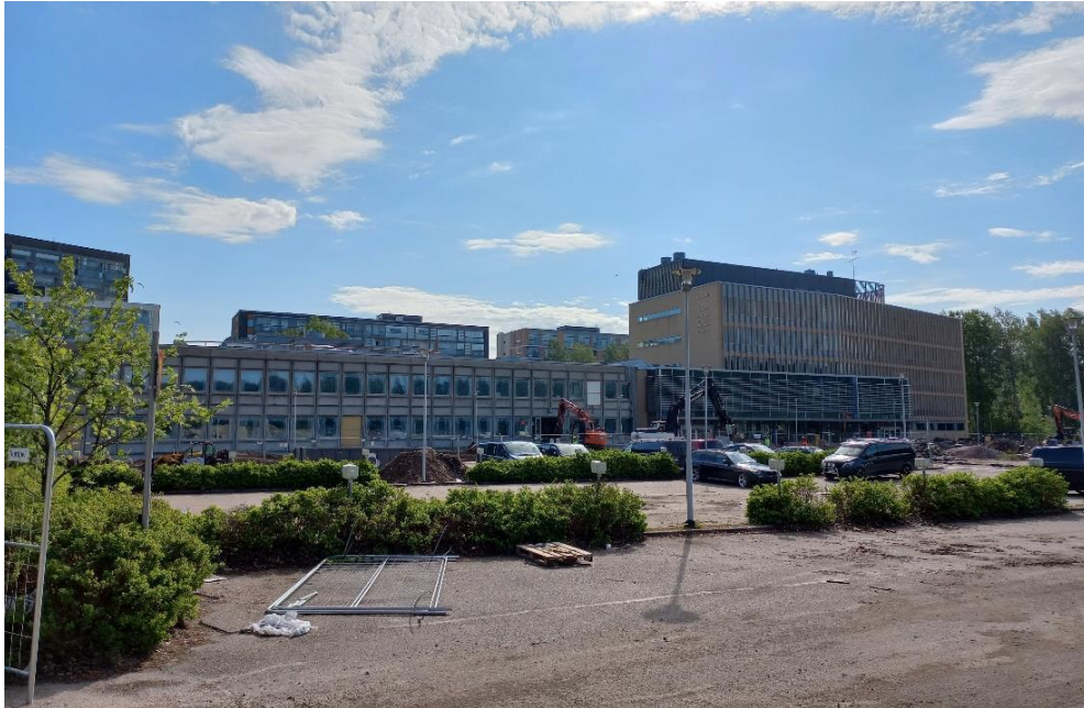
Rakennus kuvattuna lännestä.
