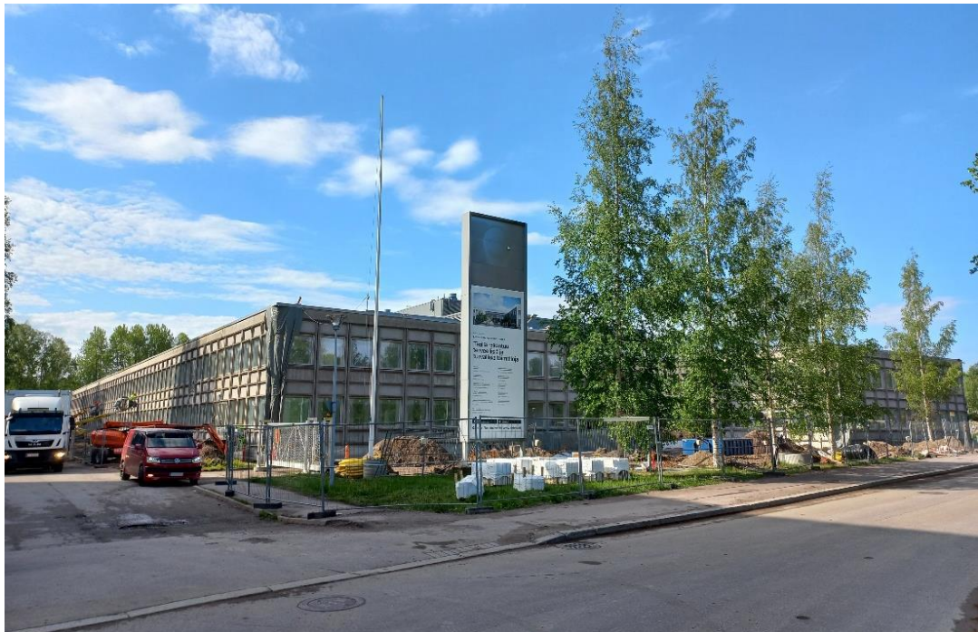
Rakennus kuvattuna pohjoisesta.
