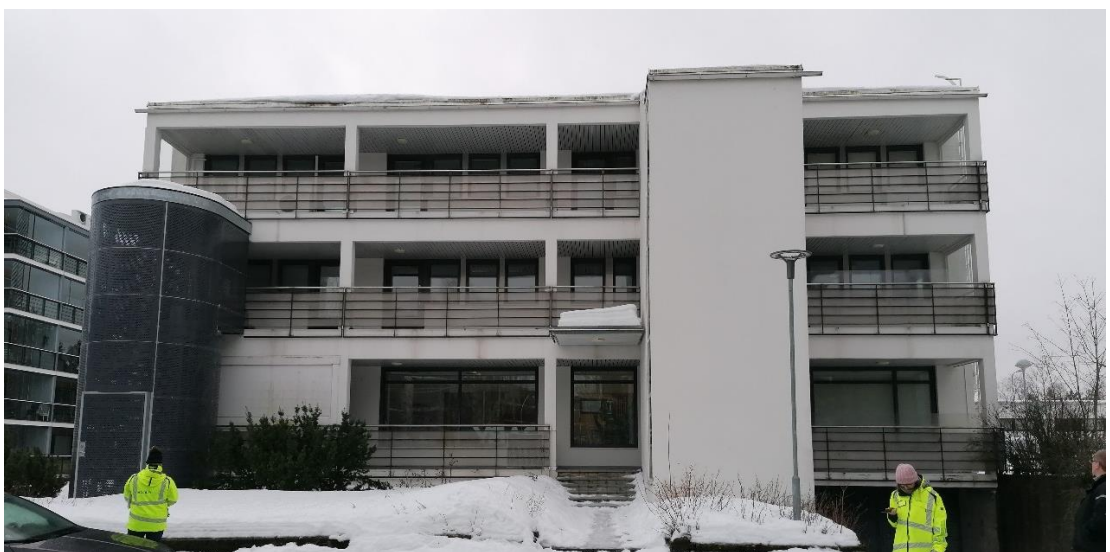
Kuva 4, Rakennuksen luhtikäytävällinen julkisivu.
