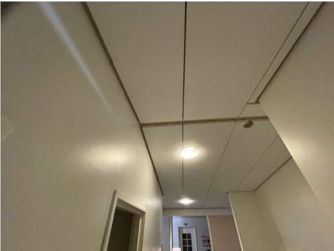
Kattopinnoissa on monin paikoin akustiikkalevyjä, joiden yläpuolella puupanelointi. Lämpökameralla havaittiin ilmavuotoa yläpohjatilasta sisätilaan.
