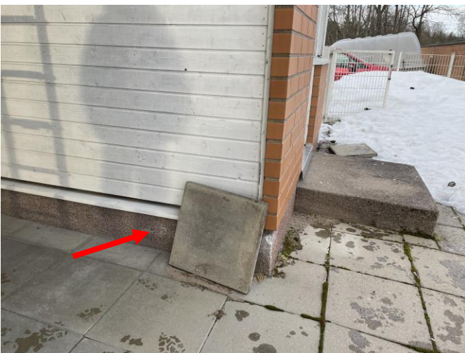
Näkymää ulkopuolelta. Kodinhoitotilan päädyssä sokkelissa on kosteusjälkeä (valkoinen kalkkihärmä). Oven edustalla on betonirakenne sekä oven pellitys.
