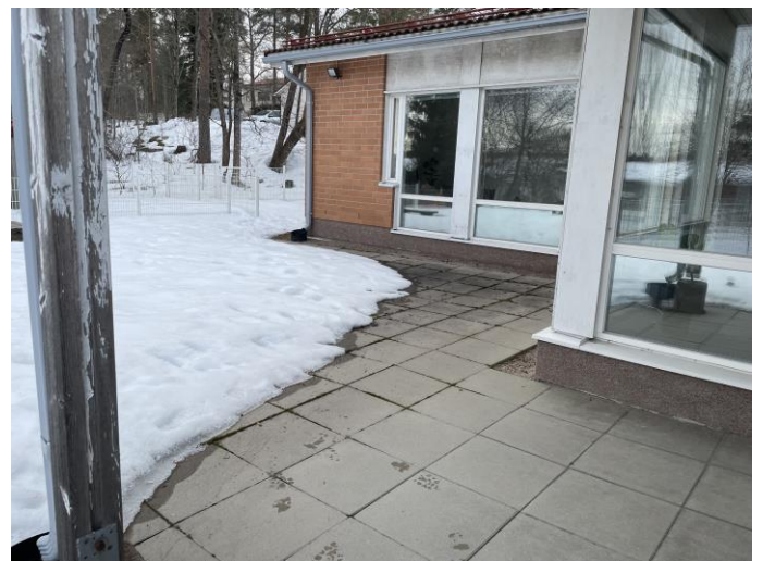
Näkymää ulkopuolelta. Kodinhoitotilan päädyssä sokkelissa on kosteusjälkeä (valkoinen kalkkihärmä). Oven edustalla on betonirakenne sekä oven pellitys.
