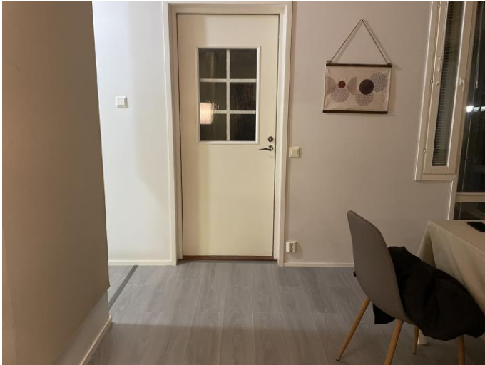
Ruokailutilasta on käynti ulos, oven edustalla ei ole pellitystä.
