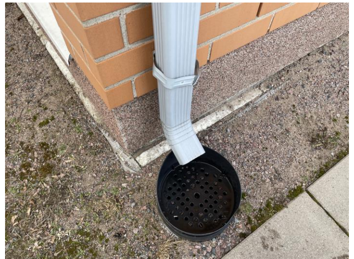
Kulmajiirin kohdalla räystäskouruissa on epätiiveyttä, vettä valuu liitoskohdista. Syksytorvien kiinnityksissä on puutteita. Julkisivun levytyksessä on kasvustoja ja likaa. Ulkona on erilaisia ulkovaloja. Sokkelin vierustalla on hiekkamaata ja hieman nurmikkoa tai sammalta.
