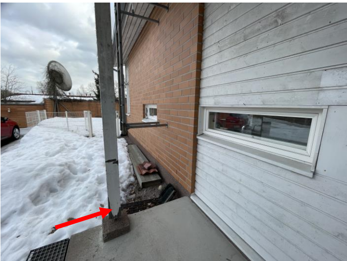
Näkymää sisääntulon kohdalta. Julkisivun laudoituksessa ja levytyksessä on näkyvää mikrobikasvustoa ja likaantumista. Puupilarissa maali irtoilee.
