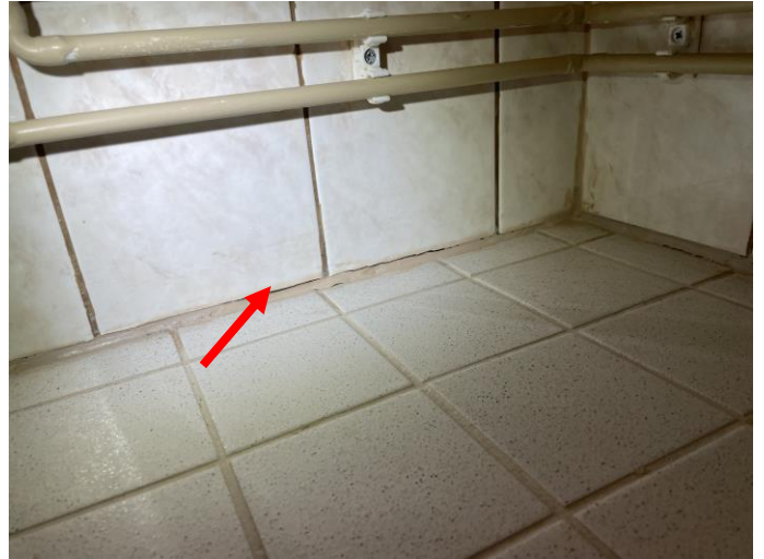
Kylpyhuoneen silikonit ovat irronneet laatoituksen liitoskohdista, sekä ikkunan reunoilta.
