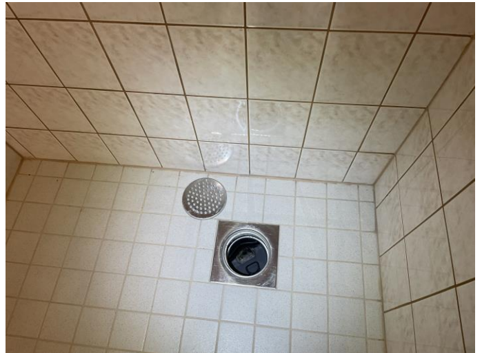
Näkymää pienemmästä kylpyhuoneesta. Puukarmeissa on kosteusjälkeä, silikonit puuttuvat. Lattiakaivo on tyhjä. Seinissä ja lattiassa on laatoitus.
