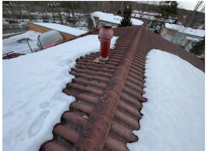
Näkymää vesikatolta. Katolla on paikoin runsaasti lunta. Tiilikatteella on sammalkasvustoa, reunoilla on lumiesteet.
