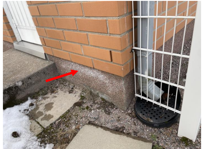
Kodinhoitotilan kohdalla syöksytorvi valuttaa vettä, kosteutta on päässyt valumaan hieman seinän puosiin ainakin ulkopuolelle.
