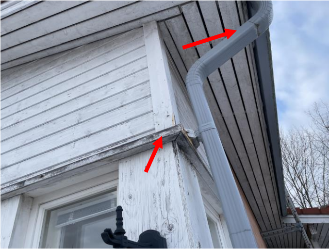
Kodinhoitotilan kohdalla syöksytorvi valuttaa vettä, kosteutta on päässyt valumaan hieman seinän puosiin ainakin ulkopuolelle.
