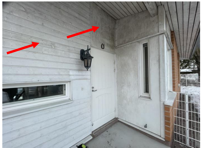
Näkymää sisääntulon kohdalta. Julkisivun laudoituksessa ja levytyksessä on näkyvää mikrobikasvustoa ja likaantumista. Puupilarissa maali irtoilee.
