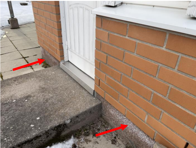
Kodinhoitotilan kohdalla syöksytorvi valuttaa vettä, kosteutta on päässyt valumaan hieman seinän puosiin ainakin ulkopuolelle.
