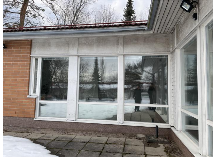
Takapihan oven edustalla on puurakenteinen porras. Ikkunoiden alaosissa on lämpökalvot.
