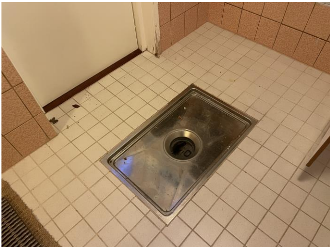
Näkymää teknisestä tilasta. Lattiakaivona on kurakaivo. Kaapissa on keskuspölynimuri, jonka yläpuolelta yläpohjasta on ilmavuotoa sisätilaan. Kohdasta tuulee tunkkaista ilmaa sisälle, höyrynsulkumuovituksen reuna näkyy. Takaoven reunoilla puurakenteissa on kosteusjälkeä.
