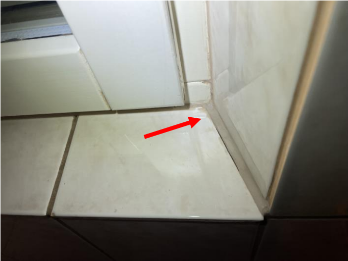
Kylpyhuoneen silikonit ovat irronneet laatoituksen liitoskohdista, sekä ikkunan reunoilta.
