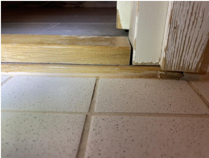
Näkymää pienemmästä kylpyhuoneesta. Puukarmeissa on kosteusjälkeä, silikonit puuttuvat. Lattiakaivo on tyhjä. Seinissä ja lattiassa on laatoitus.
