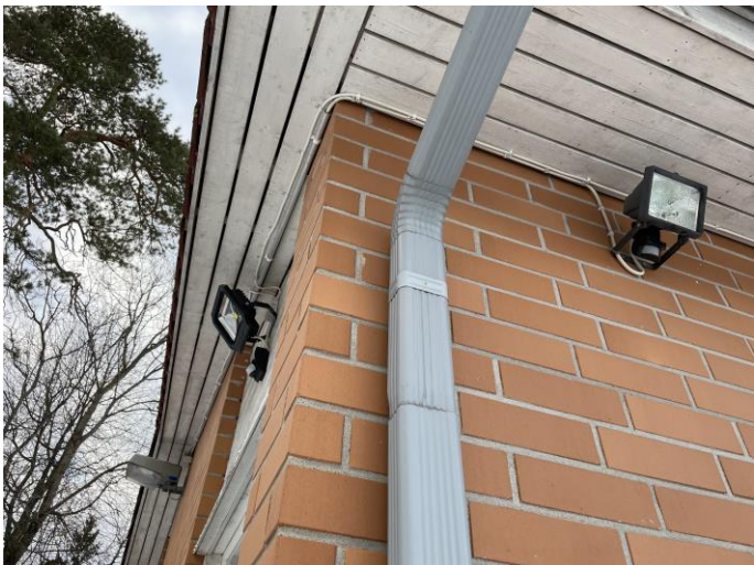
Kulmajiirin kohdalla räystäskouruissa on epätiiveyttä, vettä valuu liitoskohdista. Syksytorvien kiinnityksissä on puutteita. Julkisivun levytyksessä on kasvustoja ja likaa. Ulkona on erilaisia ulkovaloja. Sokkelin vierustalla on hiekkamaata ja hieman nurmikkoa tai sammalta.
