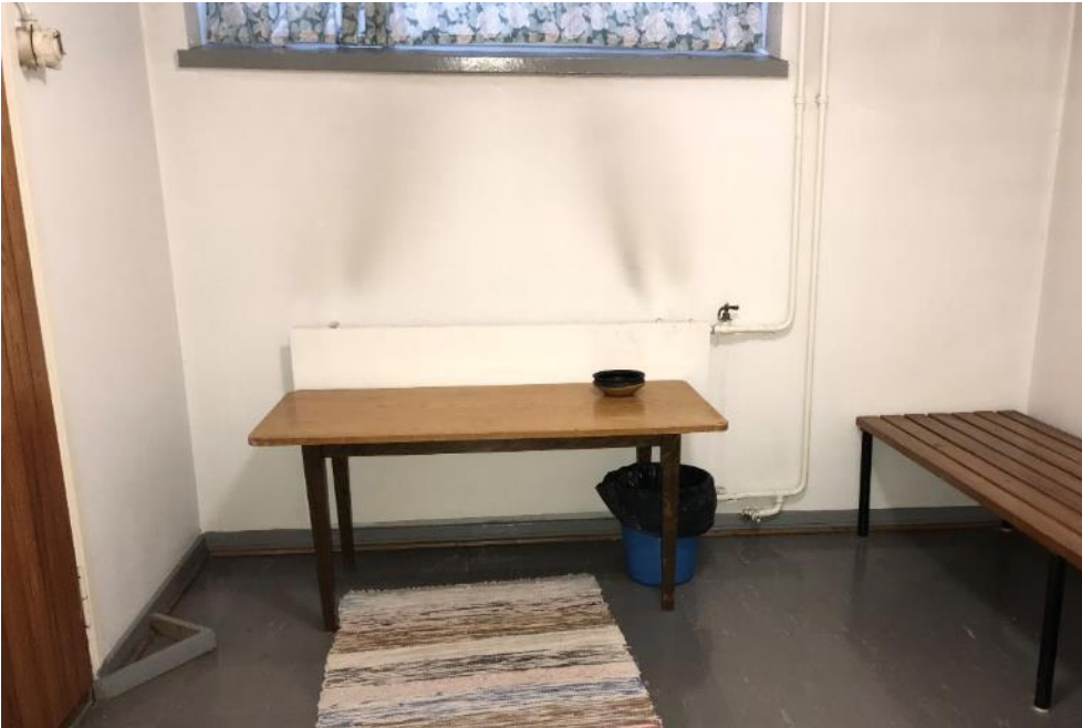
Kuva 4.6. Patterin kannakkeista on ilmavuotoa.
