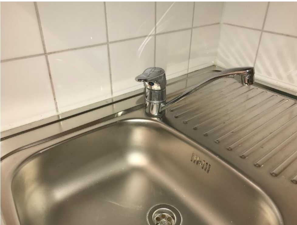
Kuva 5.6. Pesualtaan laskuhanasata puuttuu sivuliikerajoitin.
