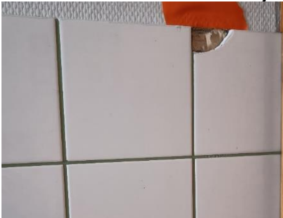
Kuva 91 Näyte 7. Vesileikkitalan 1.19 seinän valkoinen 200 x 200 mm keraaminen laatta, laasti ja liima. Ei sisällä asbestia.
