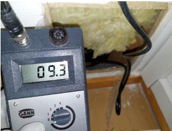
Kuva 40 Alaohjauspuun kosteus oli 9,3 p-%.
