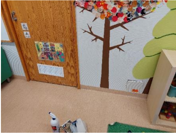
Kuva 68 Väliseinän avaus VS1 tilaan 1.73.
