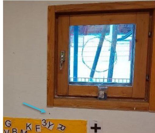
Kuva 45 Ikkunan alta mitattiin eristetilan rakennekosteus ennen avauksen US9 tekoa.
