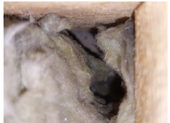
Kuva 59 Eristevillasta otettiin näyte. Avauksen kokonaissyvyys oli 195 mm.
