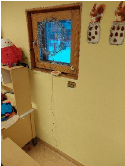
Kuva 64 US17 tilaan 1.68 pienen ikkunan alakulmaan. Avauksen alapinta oli 900 mm lattiasta.
