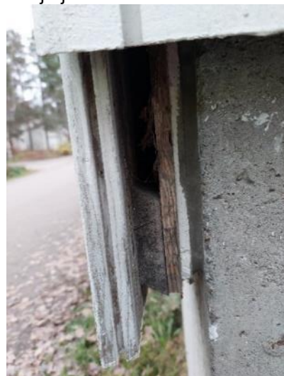
Kuva 14 Päädyssä on näkyvissä julkisivun takana oleva tuuletusrako: ohuen pystyriman jälkeen on vaakarimat ja sitten julkisivulauta.
