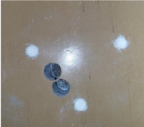
Kuva 26 Alapohjan porauksessa siivouskomerossa 1.61.
