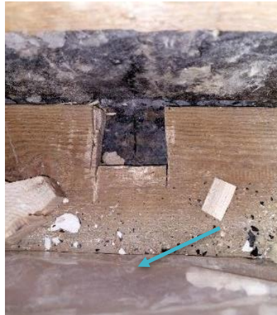
Kuva 33 Alaohjauspuun alla on bitumikerros. Muovi jatkuu alaohjauspuun alapuolelle.
