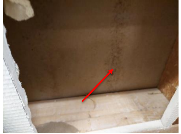
Kuva 69 Kipsilevyn paperi vaikutti kuivalta. Takaseinän paperissa on musta raita, mutta se voi olla tehdasperäinen värivirhe.
