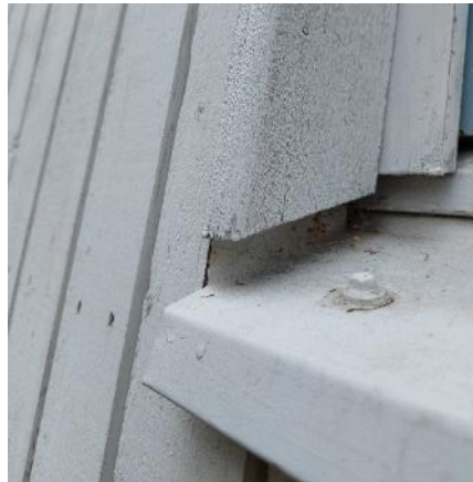
Kuva 18 Ikkunapeltien kaato on riittävä ja pelti nostettu piililaudan taakse.
