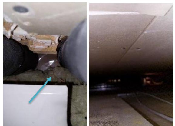
Kuva 76 Väliseinän eriste on näkyvissä alaslaskussa. Alaslaskun puolella ei havaittu kosteusjälkiä.
