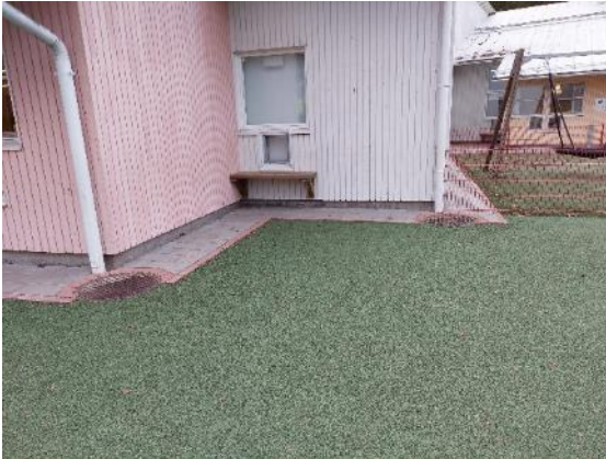
Kuva 21 Sisäpihan puolella rakennuksen ympärillä on laatoitus. Rakennuksen kulmilla on näkyvissä salaojakaivot.
