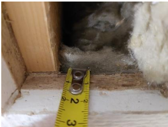
Kuva 58 Rakenne oli sisäpinnasta lukien kipsilevy 15 mm, puulevy 10 mm ja läpinäkyvä muovi.
