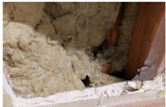
Kuva 31 Uudemman villalevyn takana oli vanhempaa villaa.
