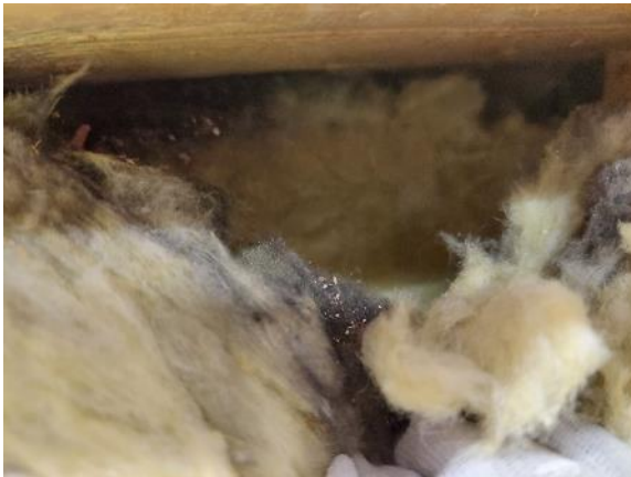
Kuva 50 US10 eristetilassa oli tummentumia.
