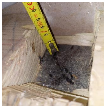
Kuva 73 Alaohjauspuu on 48 mm paksu ja sen alapuolella on bitumikermi, josta otettiin näyte haitta-aineanalyysiin.
