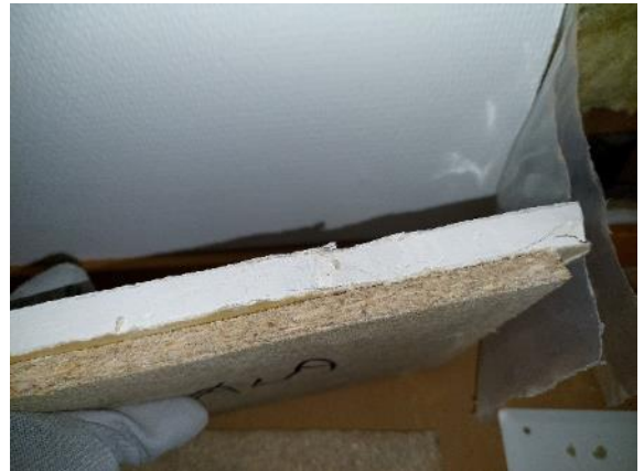
Kuva 39 Ulkoseinässä oli kipsilevyn takana myös puukuitulevy (10 mm).
