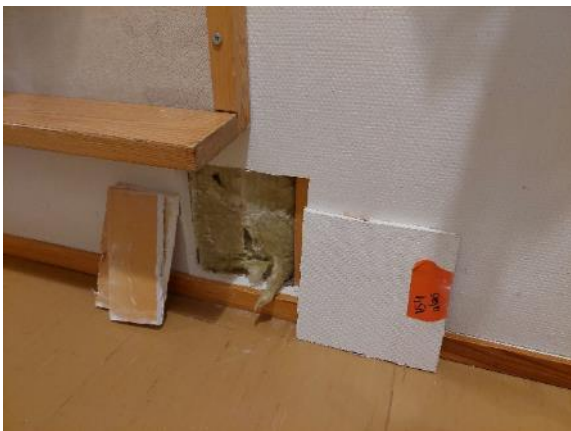
Kuva 72 Väliseinän avaus VS4 keskivaiheille käytävää 1.45. Avaus tehtiin tilan 1.36 kohdalle.
