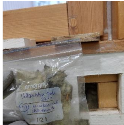
Kuva 57 US15 monitorimitilaan 1.13, josta otettiin villanäyte M19.
