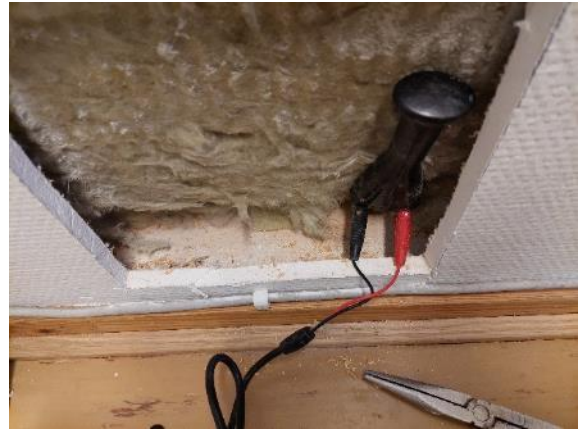
Kuva 71 Alajuoksu alkaa lattian tasolta ja se oli kuiva.
