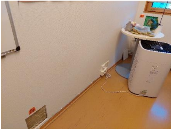
Kuva 70 Väliseinän avaus VS3 johtajan tilaan 1.07. Takana on keittiön varasto, jossa on koettu maalliarimaista hajua.
