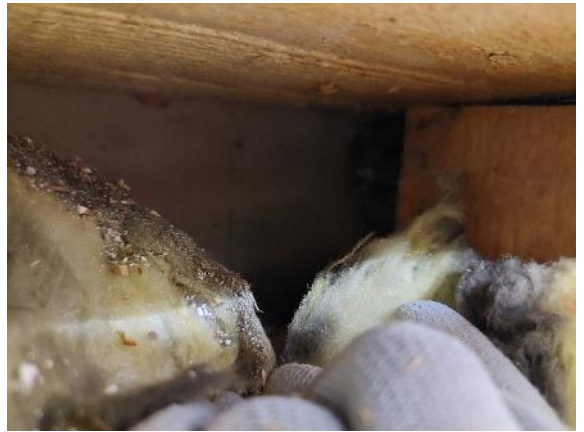
Kuva 51 Tuulensuojalevy näkyy villaeristeen takana.
