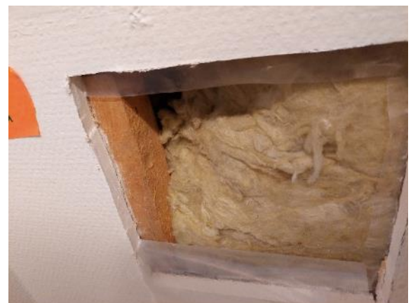
Kuva 43 US6 johtajan tilaan 1.07 ikkunan alapuolelle.
