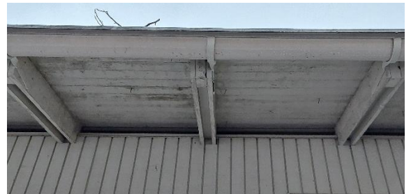
Kuva 24 Ainakin sisäpihan yläpohjan liitoskohdissa oli pieneläinverkko (ylempi kuva). Toisella puolen rakennusta ei havaittu pieneläinverkkoja.
