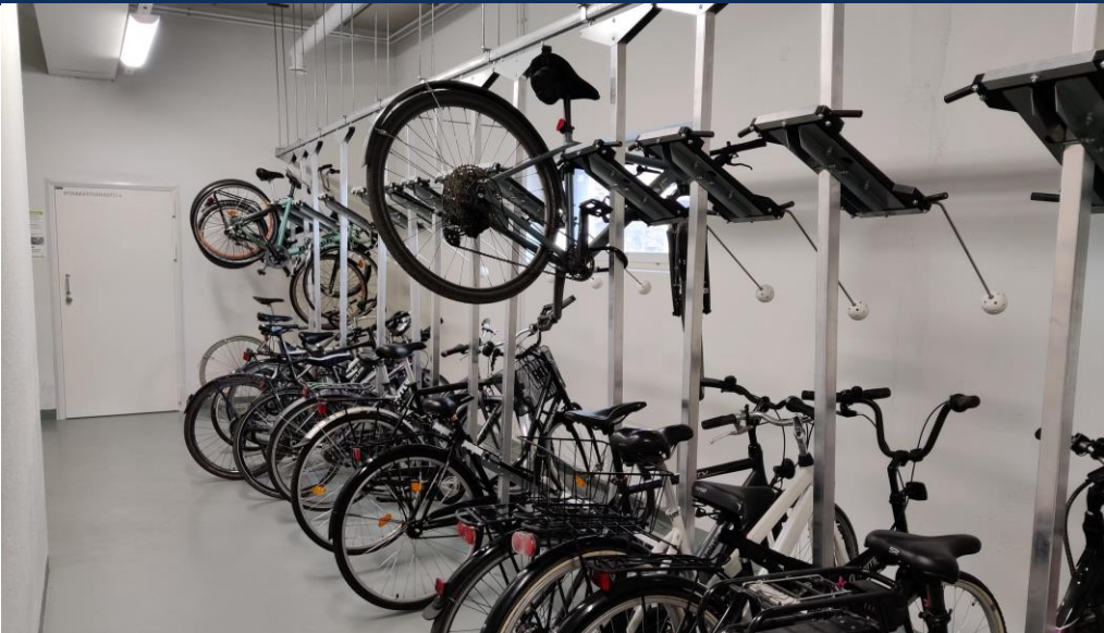
Korkea UVV-tila, jossa pyörät hyvässä järjestyksessä. 2-kerrostelineissä alapaikat olivat suosituimpia, sillä yläpaikkoihin piti nostaa pyörä itse. Yläpaikoissa eniten kevyitä urheilupyöriä.
