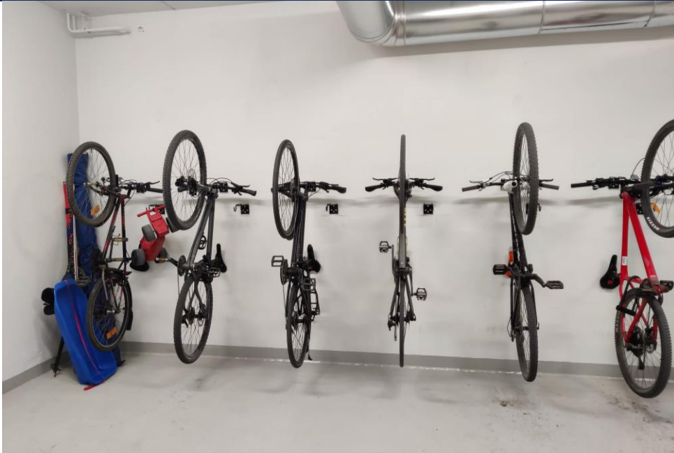
Esimerkki siitä, kuinka seinäkoukkujen asennusvälillä on merkitystä todelliseen paikkamäärään. Vain joka toinen koukku on käytettävissä.
