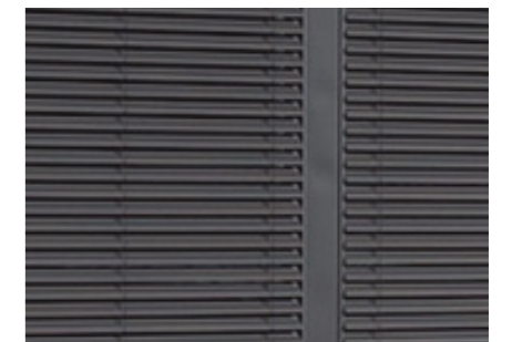
9. JULKISIVUSÄLEIKKÖ, POLTTOMAALATTU ALUMIINI TUMMANHARMAA
