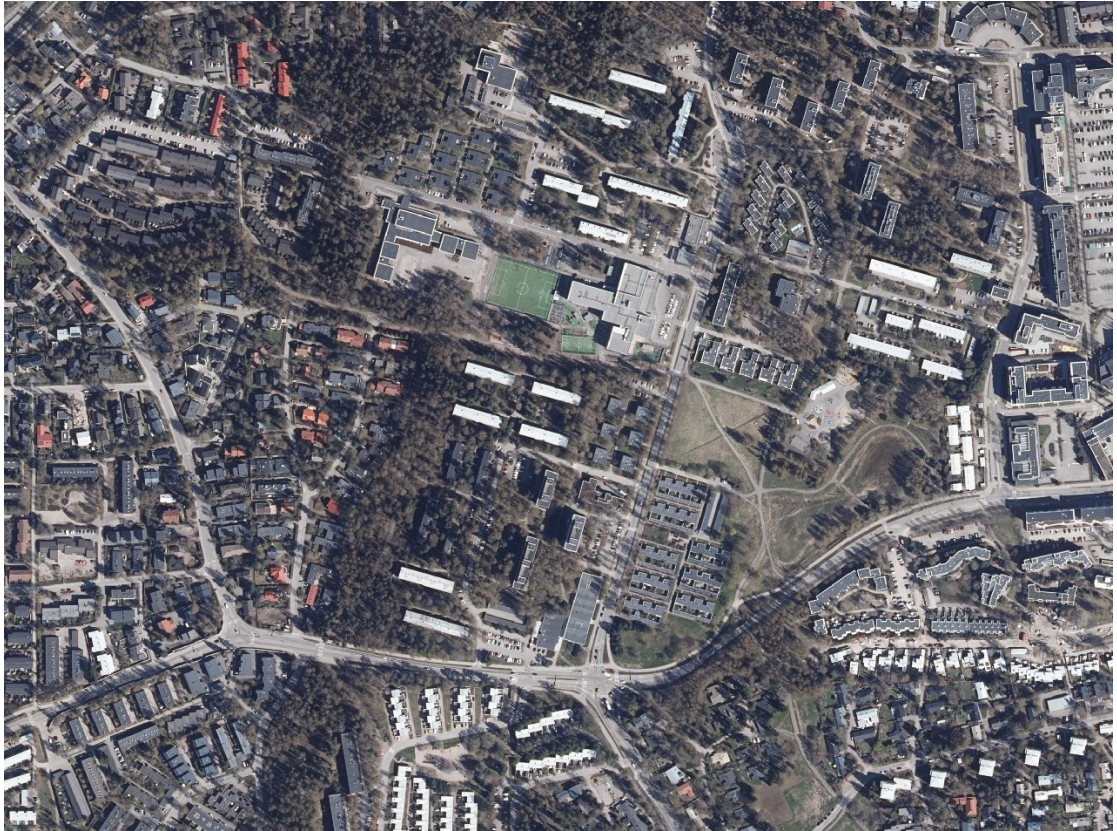
Ortokuva alueesta vuodelta 2023. Pohjois-Tapiolan lähiön korttelirakenne on säilynyt pääosin alkuperäisen rakenteen mukaisena.
