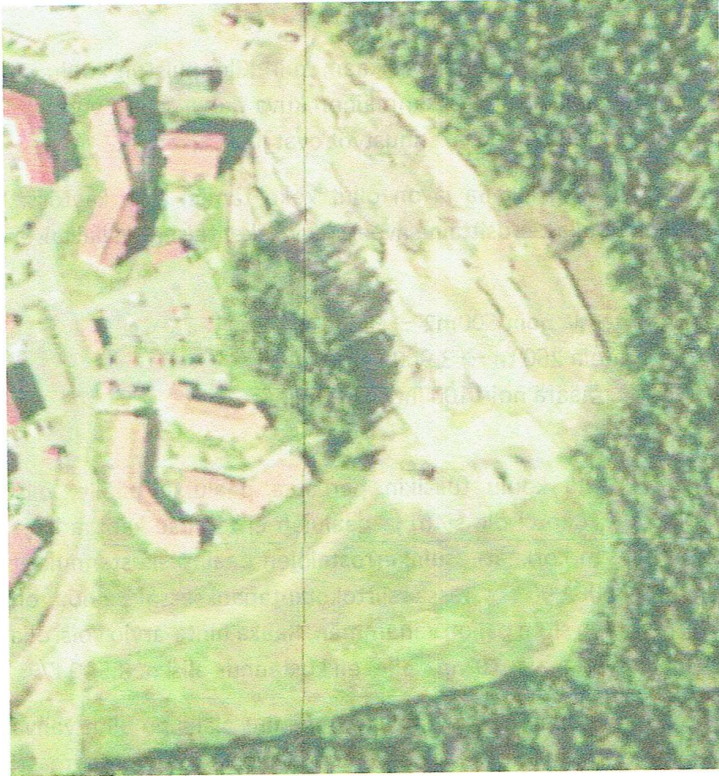
Kuva 2. Kilonpuiston koulun maanrakennustyöt, v. 2001
