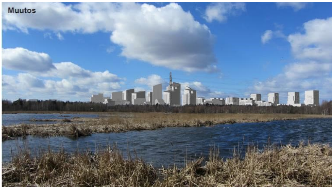
Kuva 34: Näkymä lintualtaan itäreunalta.
