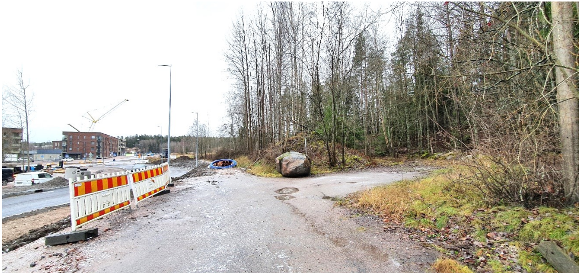
Valokuvassa Storhemtintieltä etelään näkyy kaavanmuutosalueen länsiosan entistä hiekkakuopan aluetta ja Storhemtintien kadunrakennustyömaa. Taustalla Lillhemtinkuja 2:n punatiilisiä kerrostaloja (tilanne 11/2021).
