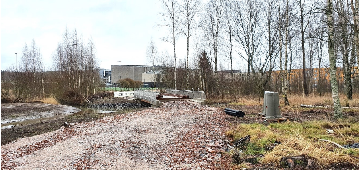
Valokuvassa kaava-alueen itäosan pohjoisreunaa rakenteilla olevalta Storhemtinsillan ulkoilureitiltä. Taustalla näkyy Opinmäen koulu (tilanne 11/2021).
