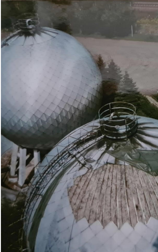
Kuva 6. Verhouksen kiinnitysvanteita pallon yläosassa.
