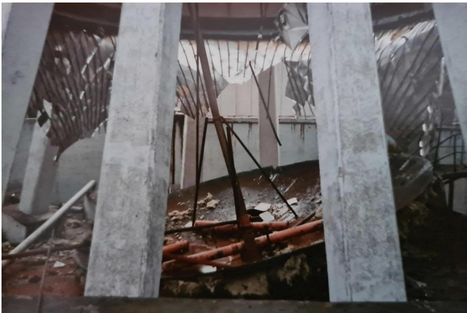
Kuva 8. Verhouksen kiinnitysvanteita pallon alaosassa.
