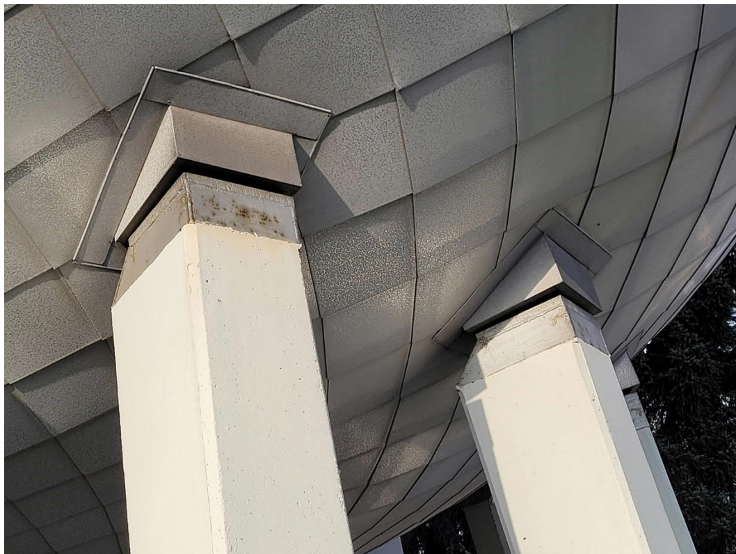
Kuva 12. Uusien pilarien päihin asennetaan nykyisiä vastaavat teräslevylaakerit.
