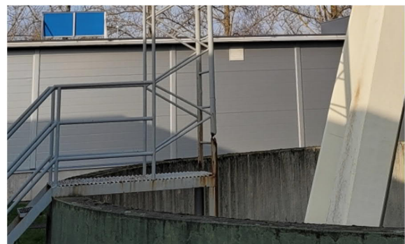
Kuva 5. Tikkaat ovat ruostuneet poikki.
