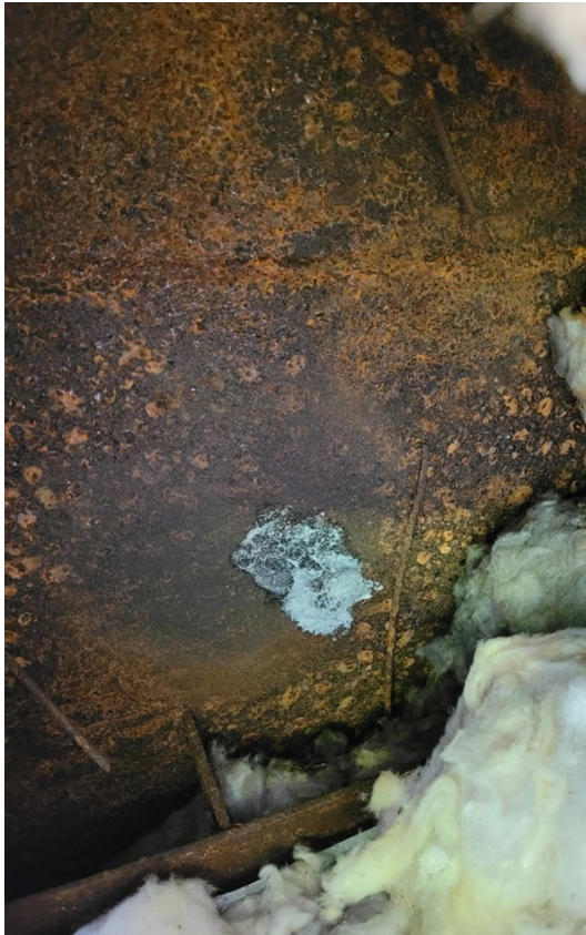
Kuva 3. Rungon ulkopintaa, seinämäpaksuuden mittauskohta (vaselliinia) ja verhouksen kiinnitysrude.
