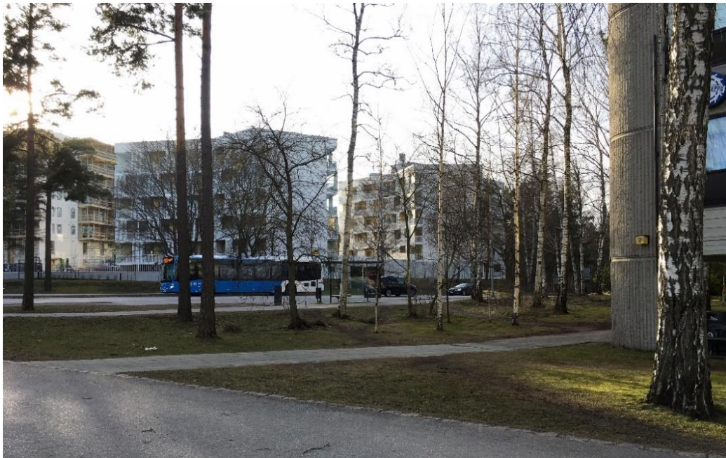
Rakenteilla oleva Ahertajankujan kerrostaloalue Pohjantien länsipuolella.
