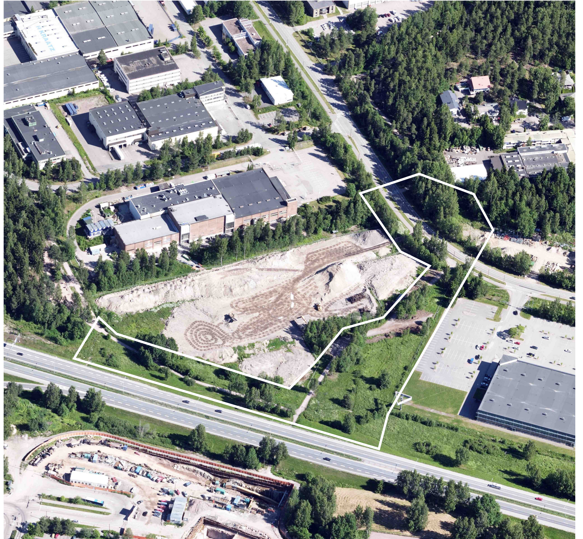
Kiviruukinaukiosta muodostuu kehittyvän Kiviruukin alueen keskeisin julkinen ulkotila. Suunnittelualue rajattuna. Ilmakuva: Espoon karttapalvelu 2017.
