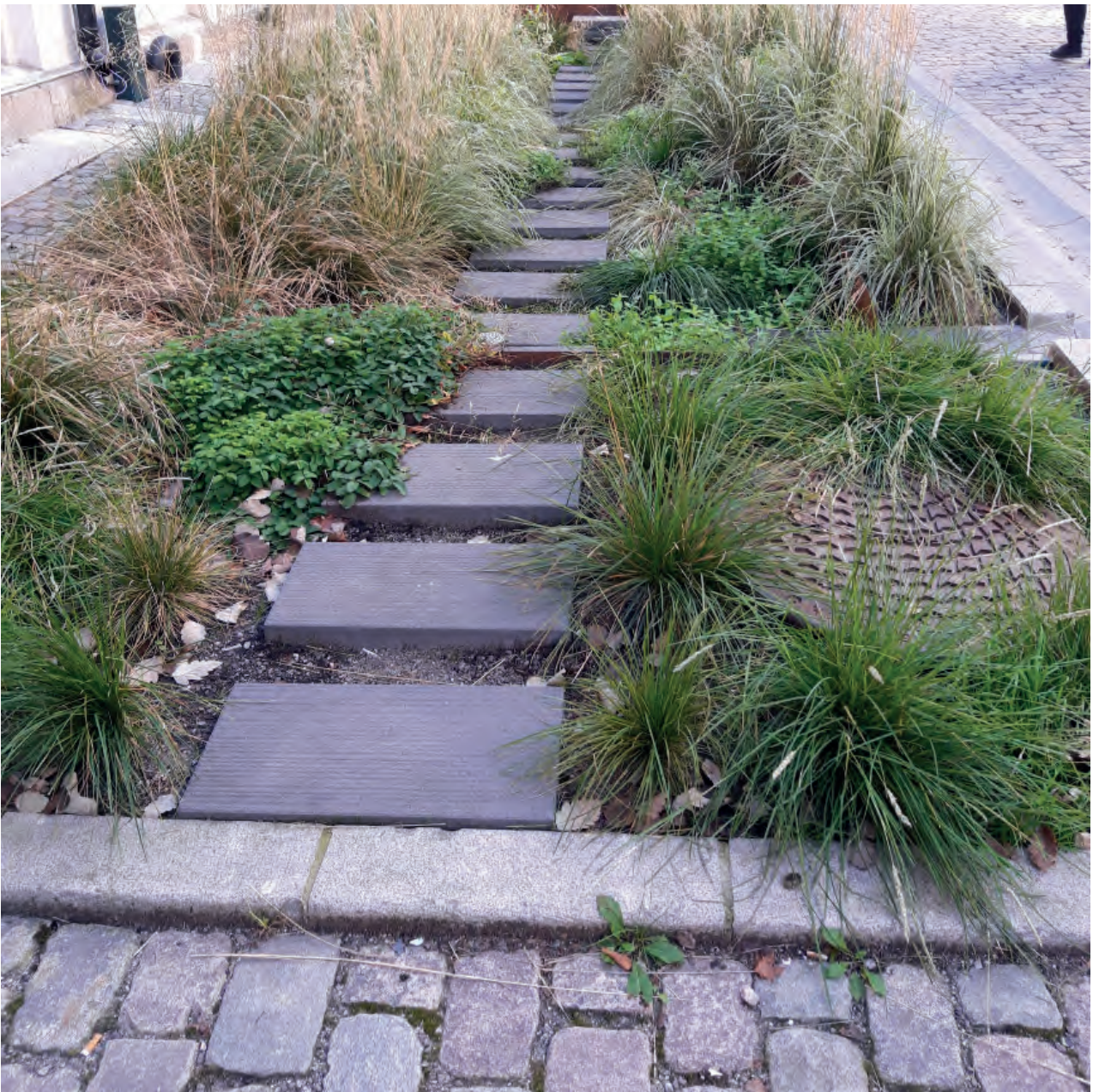
Kuva 8: Hulevesien hallintaa urbaanissa katuymppäristössä Oslolla Deichmans gate -kadulla. Luonnonmukaisen hulevesien hallinnan keinoin voidaan parantaa kaupunkikuvaa ja tuoda kaduille lisää läpäisevää pintaa ja vehereää ilmettä.
