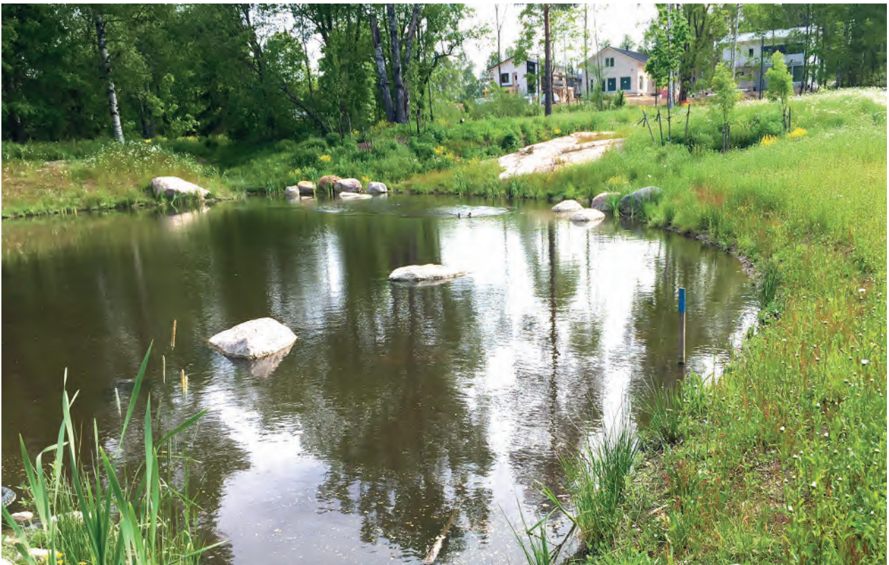
Kuva 11: Hulevesiallas Espoon Helmipöllönmäen vehreällä pientaloalueella.
