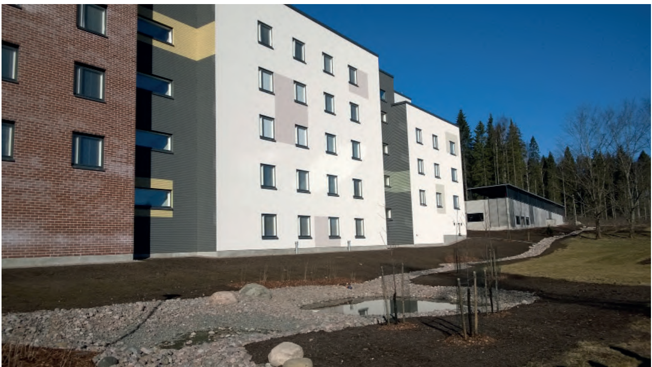
Kuva 17: Tiivistyvillä alueilla tulee varata riittävästi tilaa hulevesien hallinnan järjestämiseksi. Hulevesien hallintarakenne Vantaan Pähkinärinteessä.
