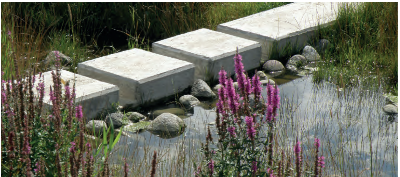
Kuva 3: Hulevesirakenne Järvenpään Lepolassa. Kuva Ramboll.
