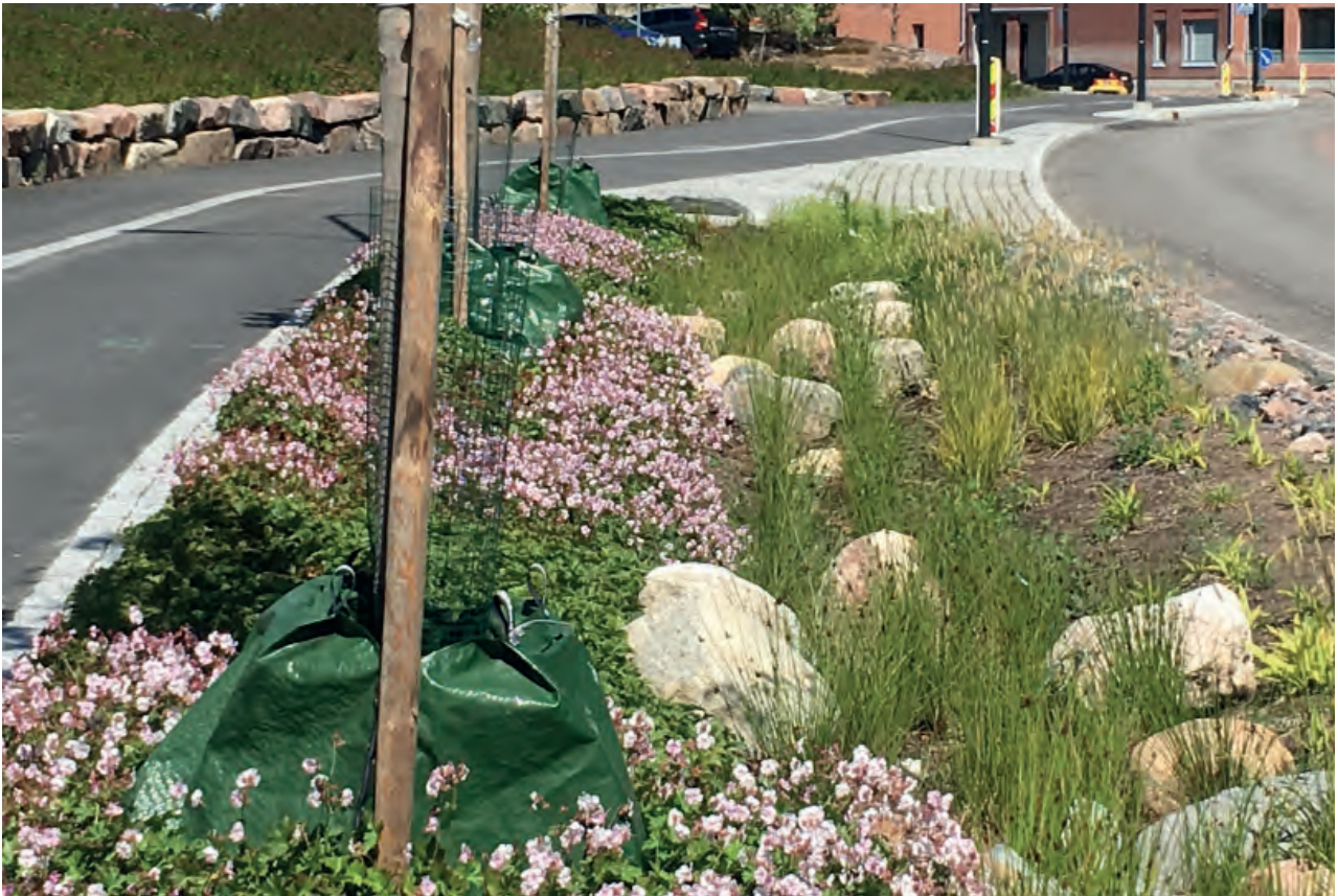
Kuva 5: Kasvullinen hulevesien imeytyspainanne Kuninkaantammen katualueella Helsingissä.
