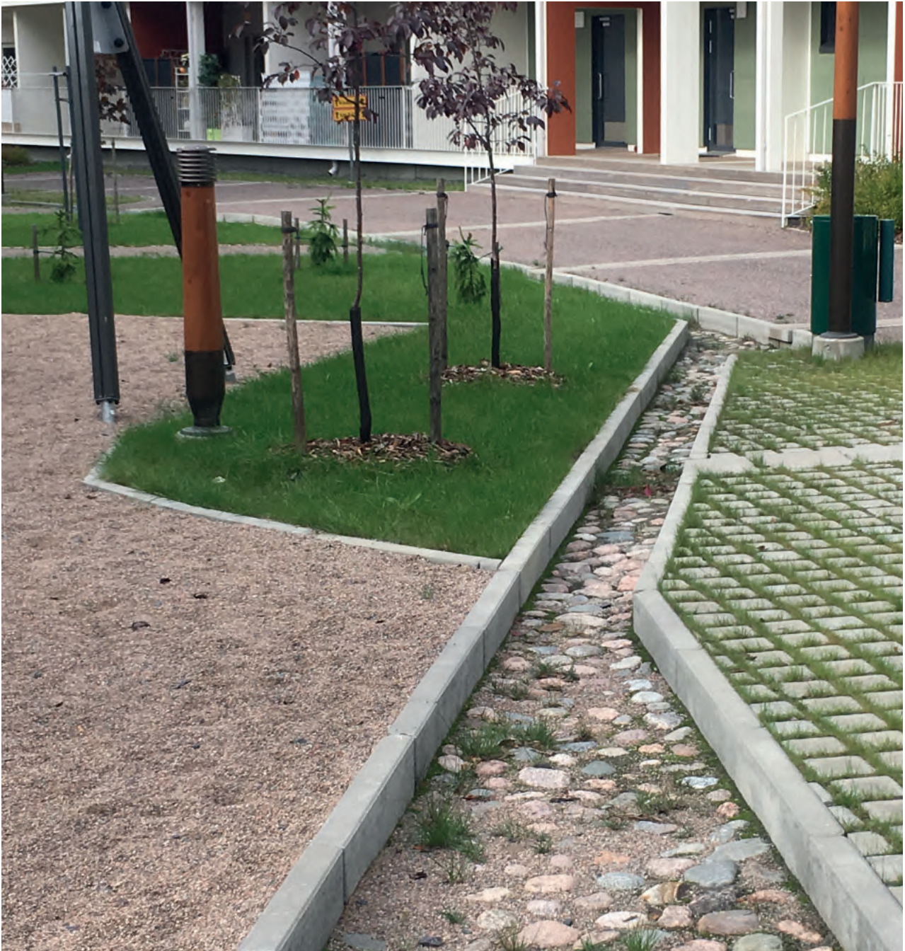
Kuva 19: Hulevesien syntypaikalla tapahtuva hulevesien hallinta on keskeinen lähtökohta Espoon hulevesien hallinnassa. Kuvassa piha Helsingin Honkasuolla.
