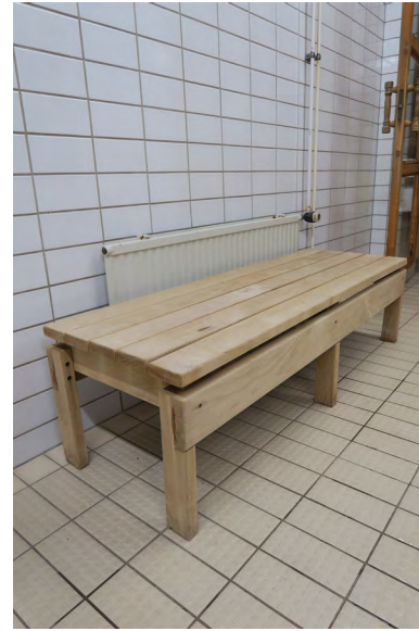
Radiaattori erityisryhmien pesuhuoneessa.
