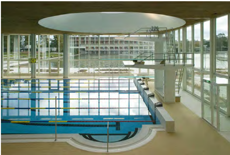
Tapiolan halli 2005 tehdyn peruskorjauksen jälkeen. Vesipinta ja lattiapinta ovat samassa tasossa. Kuva Arkkitehdit NRT Oy.
