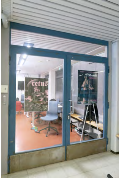
Aulojen ja pääoven ovimalli, maalattu teräsraaken- teinen lasiovi.
