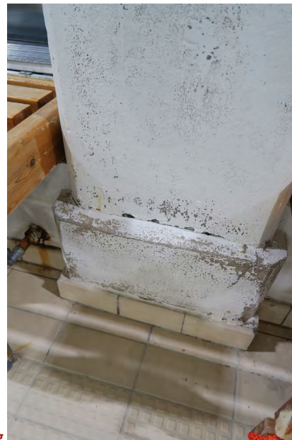
f Pilarin läpivienni allashuoneen ulkoseinällä; jälkivalettu tai laastista rakennettu sokkeli.
