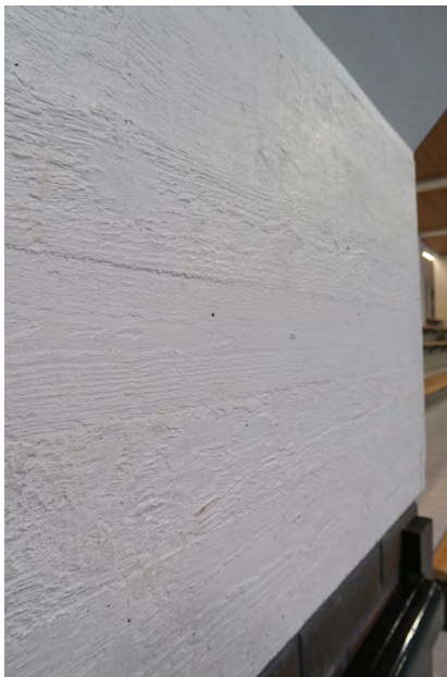
e Lautamuottipinta maalattuna, allashuoneen sisätiloissa katsomon puolella.
