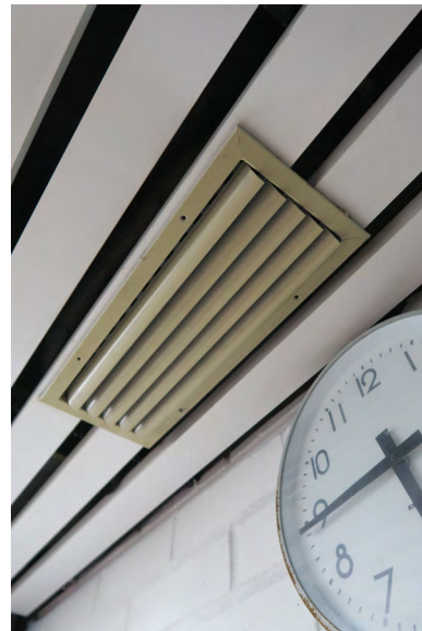
Ilmanvaihtoelemen liitos ja valkoisesta poikkeava sävy.
