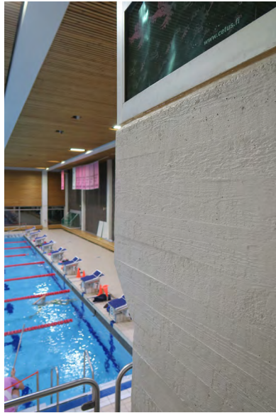
Paikalla valettua vaakalautamuottipintaista betonia, esimerkiksi allashuoneen selostamo-osassa.
