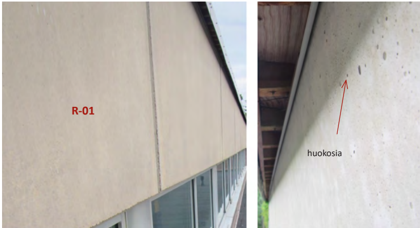
Räystään nauhaelementti. Kuvat Insinööri-toimisto Renovatek Oy, 2019.
