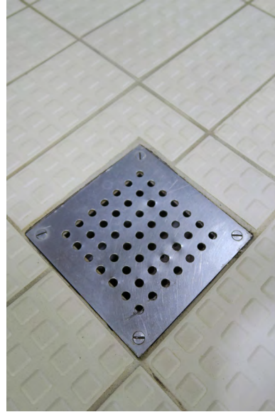
Allastason kävelyalueilla, niin allashuoneessa kuin pesuhuoneessa on beige-sävyinen nastalaatta. Altaassa väri vaihtuu valkoiseksi. Alkuperäinen lattiakaivo neilökannella suuren altaan käytävällä.
