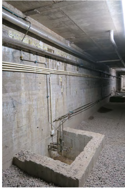
b Nostosiltojen monttu
