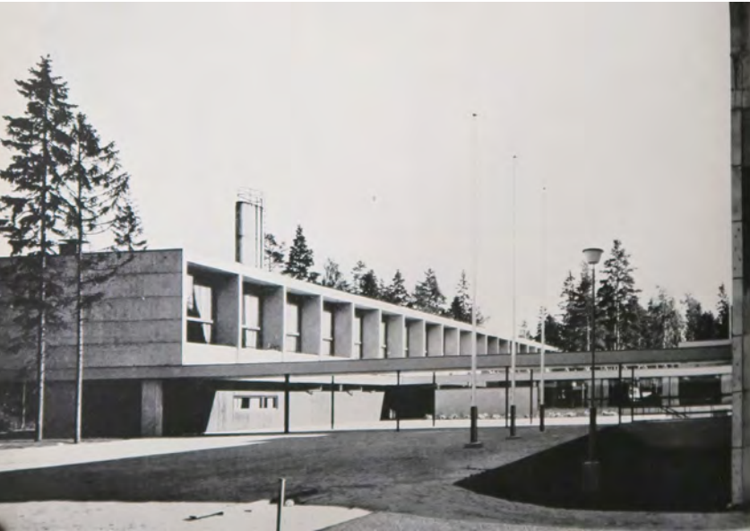
Siparin Suomalais-venäläisen koulun suunnitelma Helsinkiin sai huomattavan määrän palstatilaa Arkkitehti-lehdessä 1-2/1965. Koulu rikkaine betonista paikalla valettuine muotoineen oli edustava ja ajankohtainen. Arkkitehtuurissa on samaa tinkimättömyyttä kuin Aarno Ruusuvooren 1960-luvun merkkitoissa.
