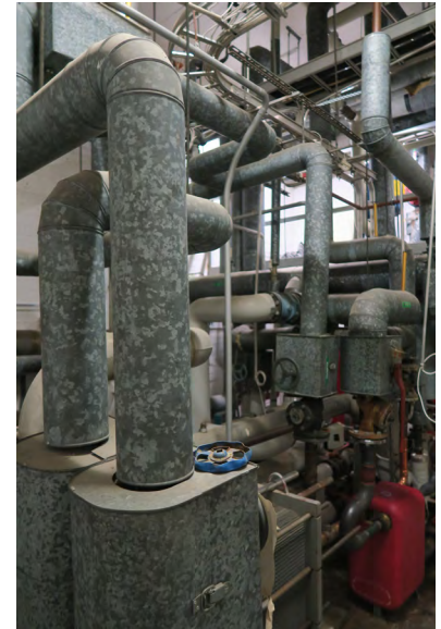
Kaukolämpöhuone lämmönvaihtimeen
