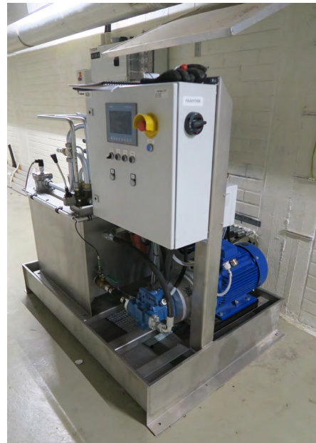
Altaan nostopohjan hydraulinostin (1/4), ryömintä- ja huoltotilan kautta katsottuna.
