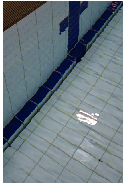
Nostopohjan ja altaan kiinteän reunuksen liitos
