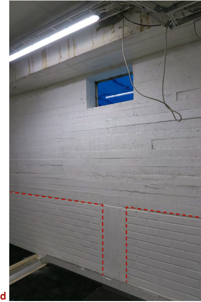
d Huoltokäytävän puolelta on havainnollisesti hahmotettavissa missä on altaan vesitiivitiin betonivalun raja, sen alla oleva palkki, pilari ja Kahi-tiilimuuraus tehty täyttö.
