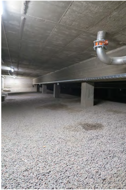
a Pääaltaan alustila; paikalla valettuja rakenteita vesitiivistä betonista.
