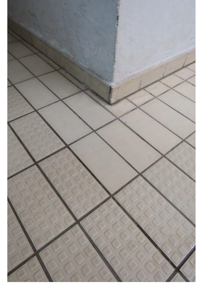
Esimerkki seinän vierustasta, missä kahden sileän laatan muodostama kehysalue. Alla vastaava pukuhuoneesta, missä klinkkerin sävy on tiilenpunainen.
