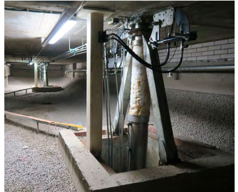
Altaan nostopohjan hydraulinostin (1/4), ryömintä- ja huoltotilan kautta katsottuna.
