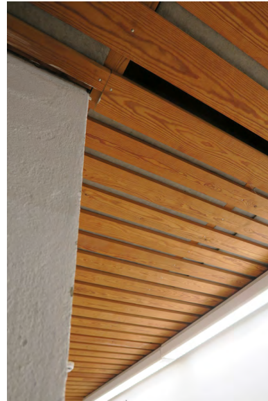
Avosauomaista mäntylautaa ja sen yläpuolella välittömästi akustoiva materiaali. Allashuoneen erikoisryhmien pukuhuoneeseen johtava käytävä
