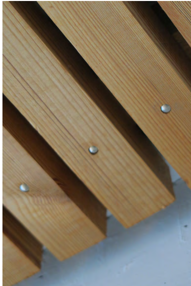
Mäntyrimoitusta allashuoneessa. Kiinnityksenä siisti liinsikantainen viimeistelynaula. Pintakäsittelykerros on hyvin ohut.
