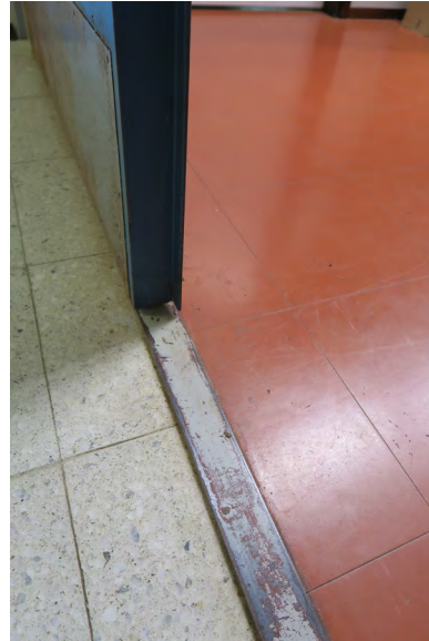
Finnflex kvartsivinyylilaatta; tyypillisin väri
