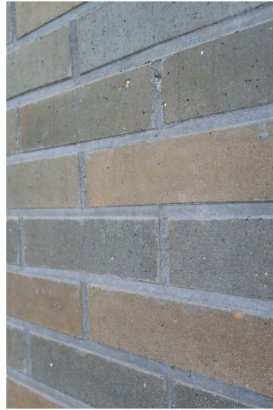
Puhtaaksi muurattua julkisivutiiltä mustanharmaalla saumalla, esimerkiksi allashuoneessa.
