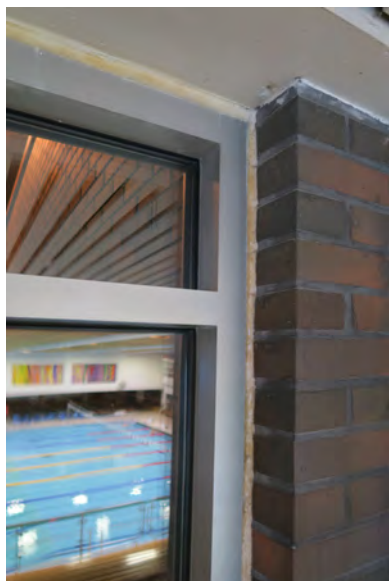
Alumiini-ikkunat allashuoneissa...
