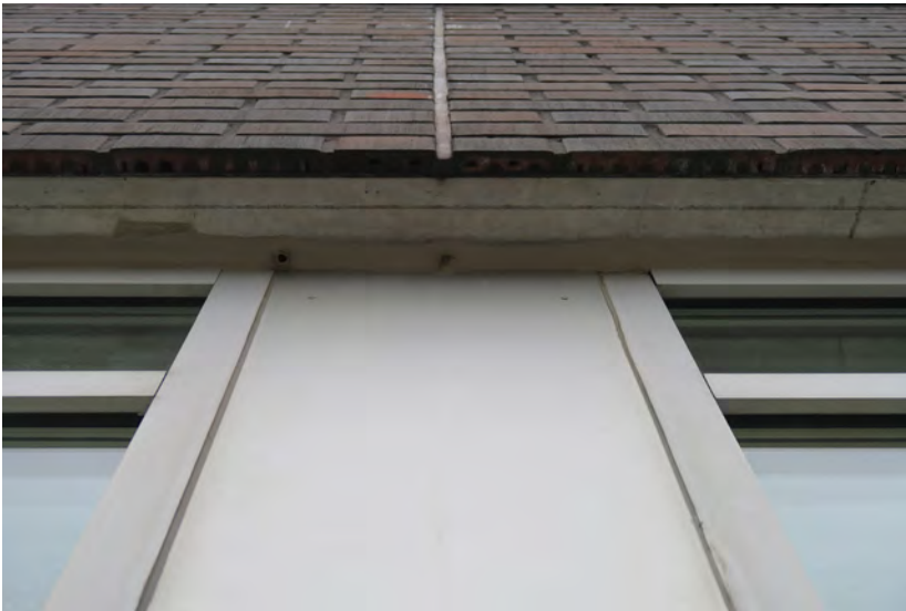
Räystään nauhaelementti. Kuvat Insinööri-toimisto Renovatek Oy, 2019.
