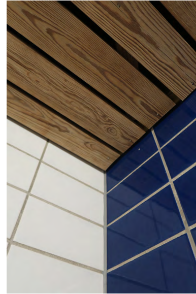
Avosauomainen laudoitus pesuhuoneessa.
