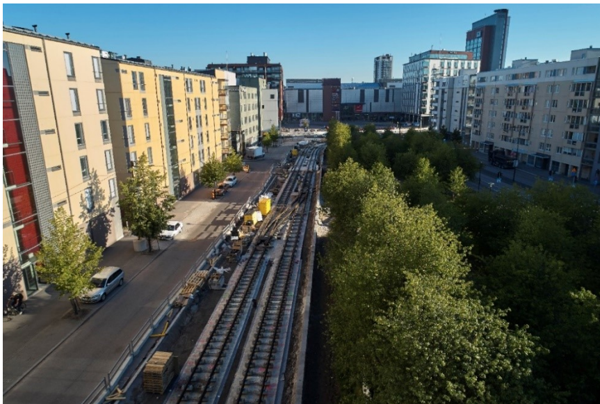
Raide-Jokerin raiteiden rakentamista Leppävaarassa elokuussa 2020 Kuva: Olli Urpela
