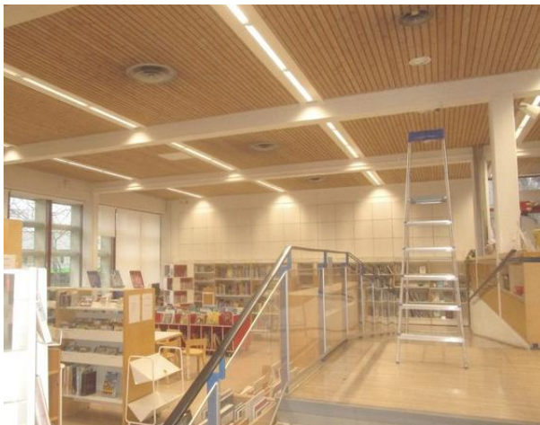
Kuvat 58 ja 59. Alkuperäisiä tuloilmalaitteita kirjastosalissa.
