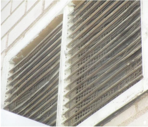
Kuvat 54 ja 55. Ulkoilmasäleikkö on ns. vakiosäleikkö, jonka metalliverkko on rikki. Punainen tuloilmasuodatin on F7-tasoinen. Lämmityspatterissa on epäpuhtauksia. Kotelon sisäpinoilla on huonokuntoista tummaa vaimennusmateriaalia.
