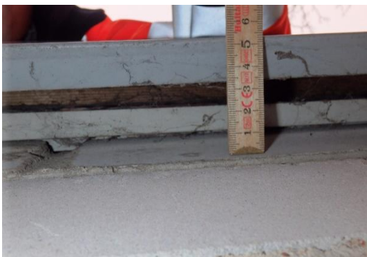
Kuva 30. Räystäät ovat hyvin kapeat. Räystäässä on myrskypelti.
