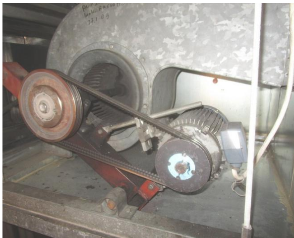
Kuvat 56 ja 57. Tuloilmapuhallin on vanha, puhaltimen hihna oli kunnossa. Kotelossa on reikiä ja luukkujen tiivistys on puutteellinen.
