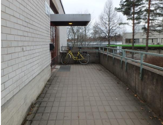
Kuvat 3 ja 4. Kirjaston sisäänkäynnin laatoitus on painunut, ja voi lammikoida. Pohjoissivun terassin laatoitus on hyvin tasainen. Sadevedet on pyritty ohjaamaan laatoitetulta alueelta sadevesikaivoihin.
