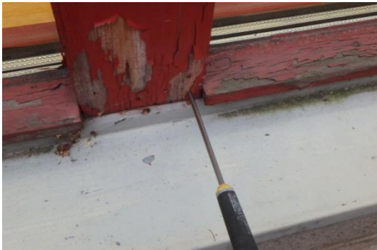
Kuvat 33 ja 34. Puuikkunat ovat välttävissä kunnossa. Ulkopuitteiden puuosat ovat jo pehmenneet. Vesipeltien kaato on hyvin loiva ja pelleille kerääntyy roskaa.
