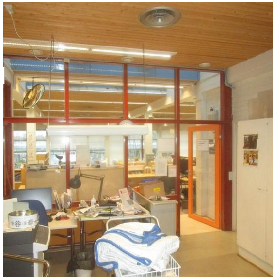
Kuvat 58 ja 59. Alkuperäisiä tuloilmalaitteita kirjastosalissa.
