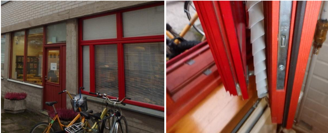
Kuvat 37 ja 38. Uusitut puu-alumiini ikkunat ovat hyvässä kunnossa. Uusittujen ikkunoiden vesipeltien kallistus on alkuperäisiä parempi.
