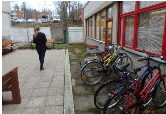
Kuvat 3 ja 4. Kirjaston sisäänkäynnin laatoitus on painunut, ja voi lammikoida. Pohjoissivun terassin laatoitus on hyvin tasainen. Sadevedet on pyritty ohjaamaan laatoitetulta alueelta sadevesikaivoihin.
