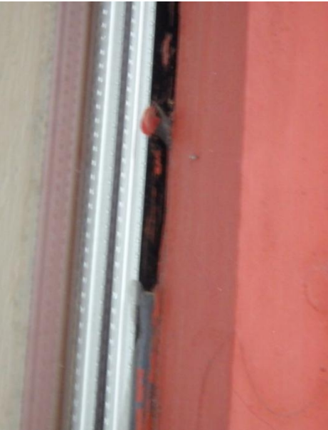
Kuvat 35 ja 36. Kirjastosalin ikkunoiden ulkopuoleiset silikonisaumat ovat auki, mikä on voinut aiheuttaa edellisen vesivuodon.
