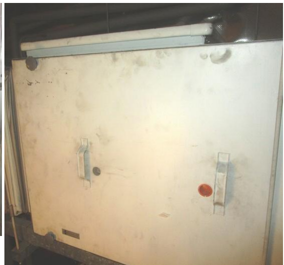
Kuvat 56 ja 57. Tuloilmapuhallin on vanha, puhaltimen hihna oli kunnossa. Kotelossa on reikiä ja luukkujen tiivistys on puutteellinen.
