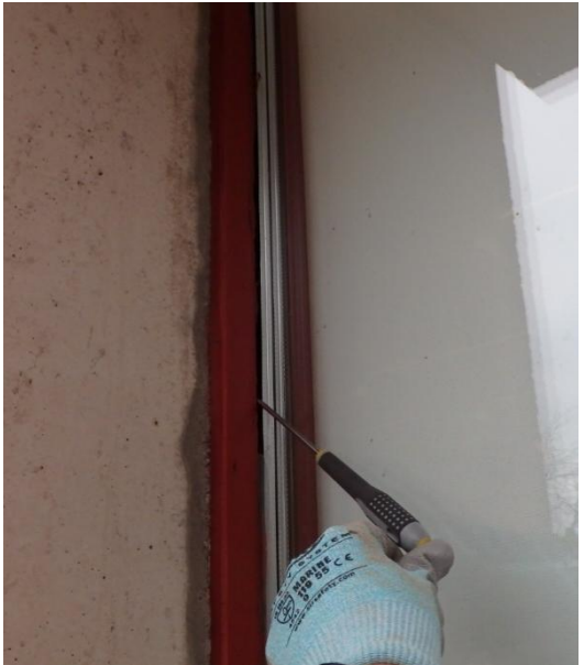
Kuvat 35 ja 36. Kirjastosalin ikkunoiden ulkopuoleiset silikonisaumat ovat auki, mikä on voinut aiheuttaa edellisen vesivuodon.
