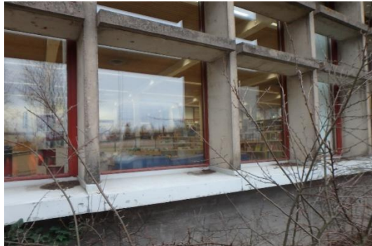
Kuvat 33 ja 34. Puuikkunat ovat välttävissä kunnossa. Ulkopuitteiden puuosat ovat jo pehmenneet. Vesipeltien kaato on hyvin loiva ja pelleille kerääntyy roskaa.
